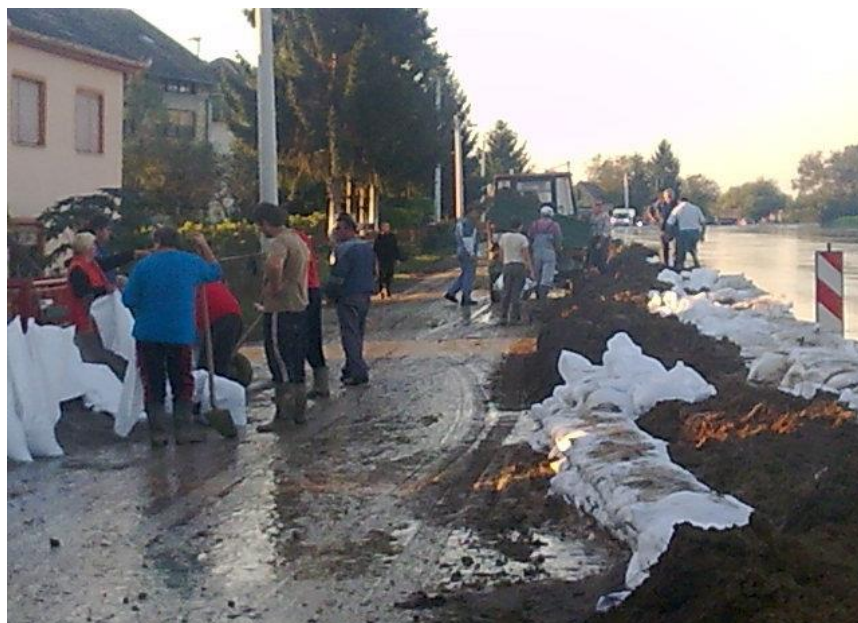
Slika 38. Rijeka Sava 20.09.2010. – izrada tzv. „zečjih nasipa“ [12]
