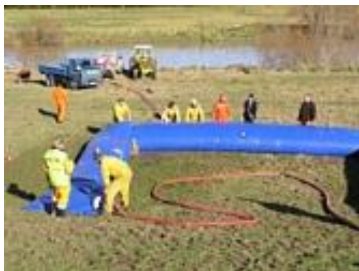
Slika 23. Postavljanje pregrade kako bi se dokazalo brtvljenje između dvije pregrade [7]
