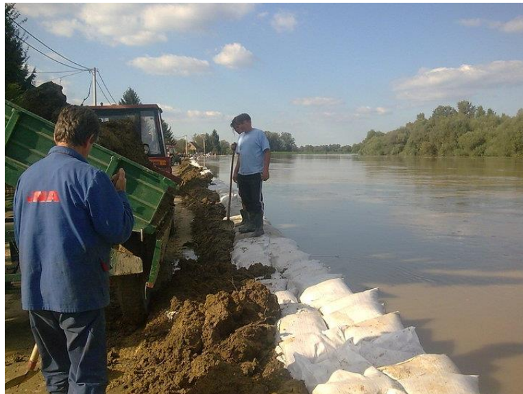
Slika 37. Rijeka Sava 20.09.2010. – izrada tzv. „zečjih nasipa“ [12]
