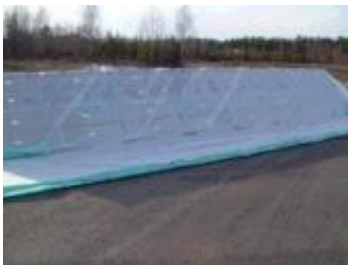
Slika 6. Platna prekrivaju prednji dio pregrade [3]
