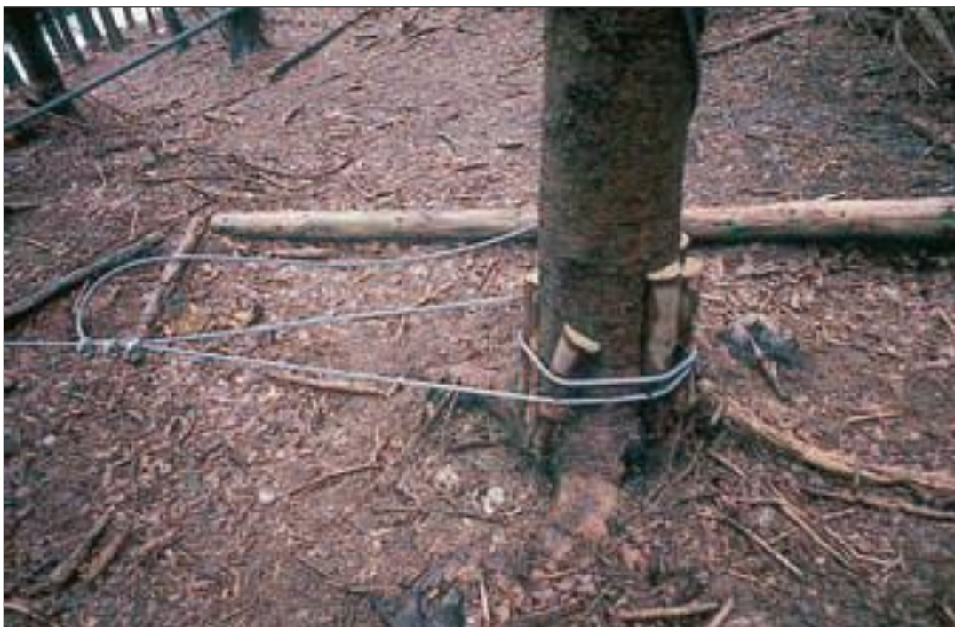
Slika12: Sidrenje užeta na stablo (Seilgelaender_kroat_web(2).pdf)
