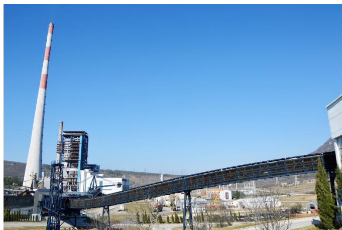
Slika 5. Traka kojom ugljen dolazi na deponij. [10]
