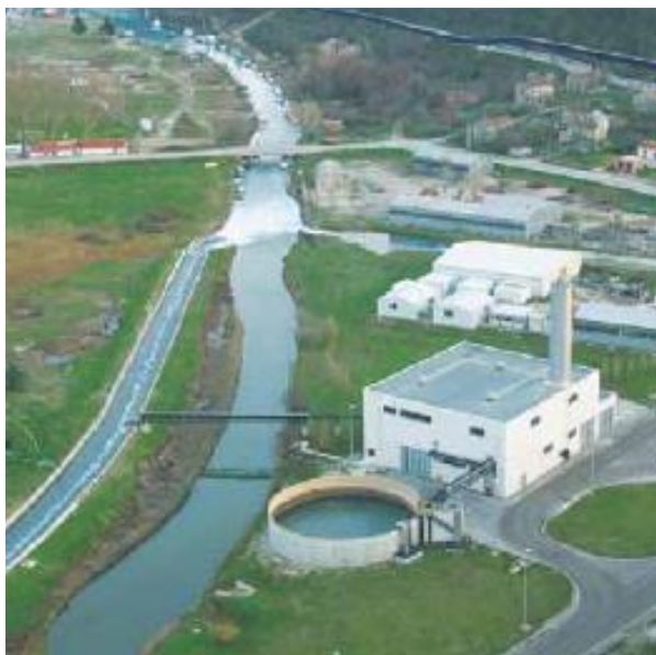
Slika 9. Postrojenje za obradu otpadnih voda. [13]
