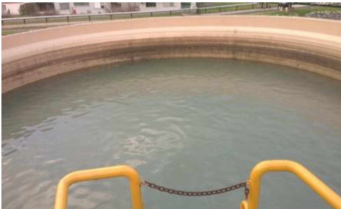
Slika 14. Međubazen (tampon-bazen) sustava ARA.
