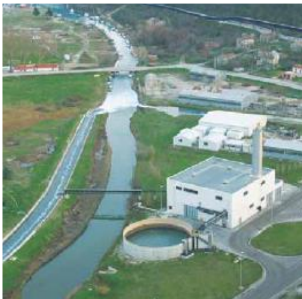
Slika 9. Postrojenje za obradu otpadnih voda. [13]
