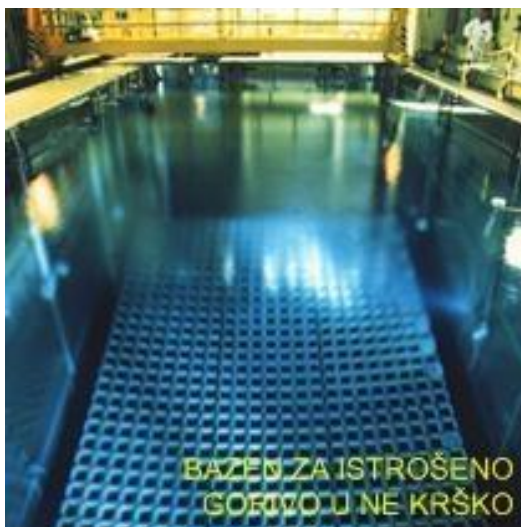
Slika 9. Voda kao zaštita od radioaktivnog zračenja istrošenog goriva
