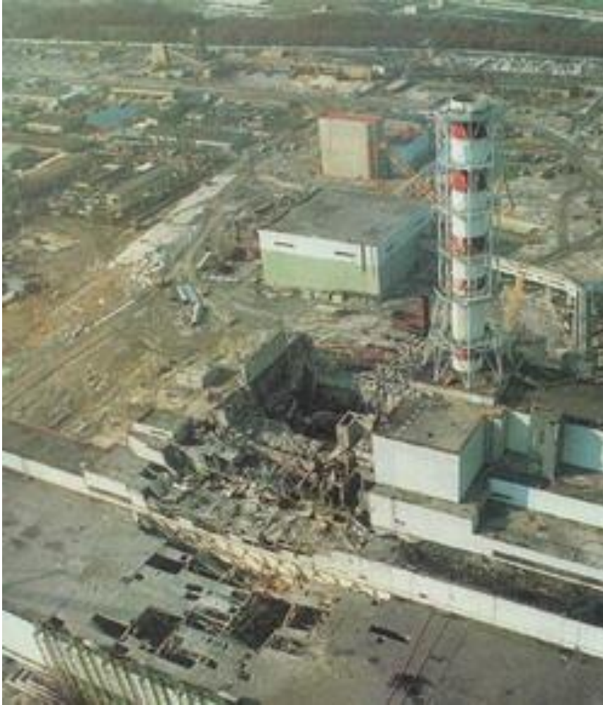
Slika 14. Nuklearni reaktor broj četiri nakon eksplozije. Vidljiva su znatna oštećenja reaktora (u sredini) i generatorske zgrade (dolje).
