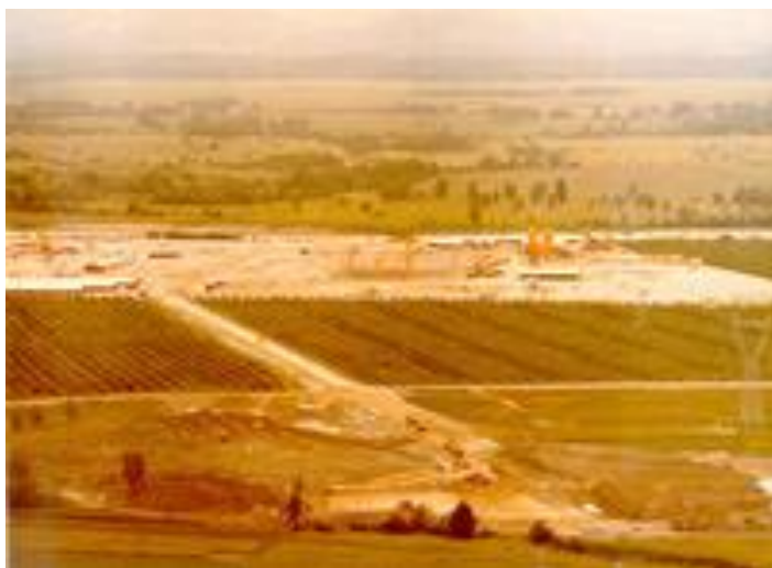
Slika 2. 1975. – početak iskopavanja i građevinskih radova na gradilištu
