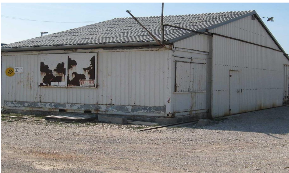
Slika 10. Poljoprivredno skladišni prostor[15]
