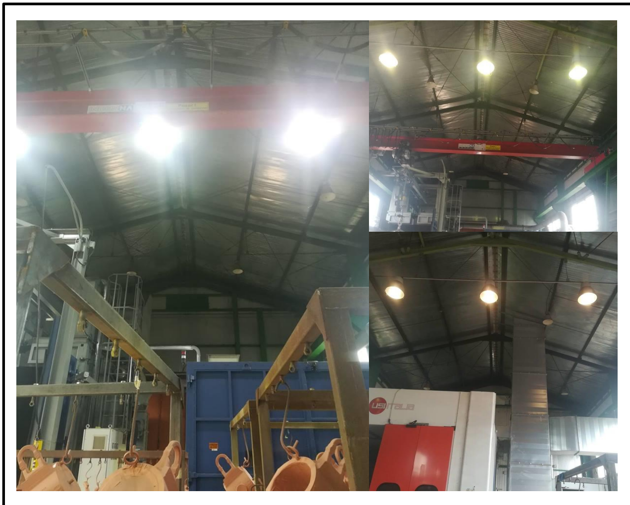
Slika 21: Pogon lakirnice i antikorozivne zaštite
