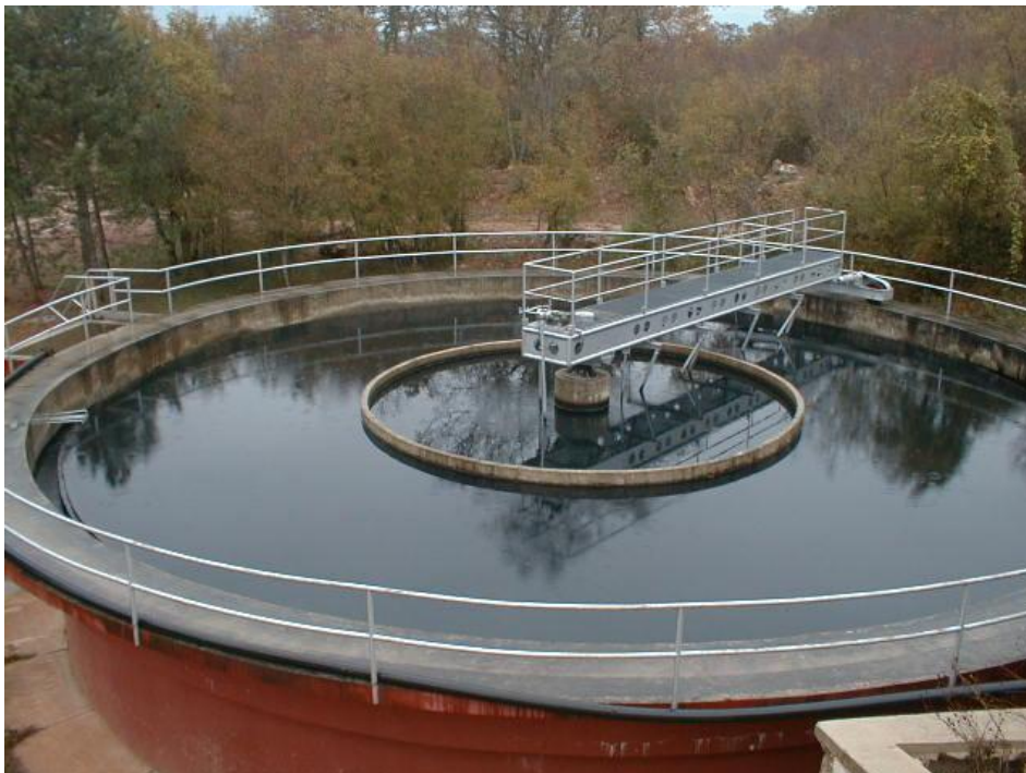
Slika 14. Bazen za flokulaciju
