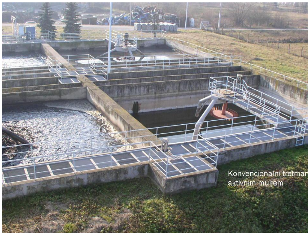
Slika 16. Bazeni za konvencionalni tretman
