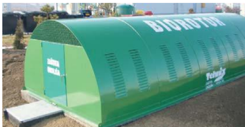
Slika 20. Natkriveni biodiskovi
