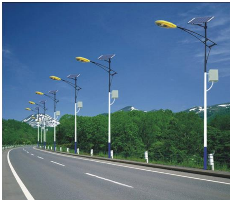
Slika 3. Primjena solarne javne rasvjete uz prometnicu
