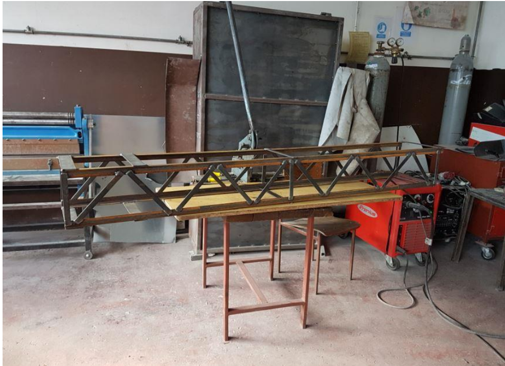
Slika 66.: Zavarivanje stranica konstrukcije
