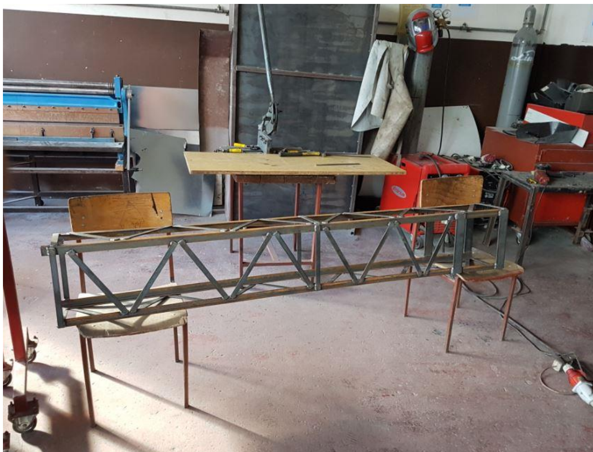
Slika 68.: Zavarivanje ostalih stranica konstrukcije
