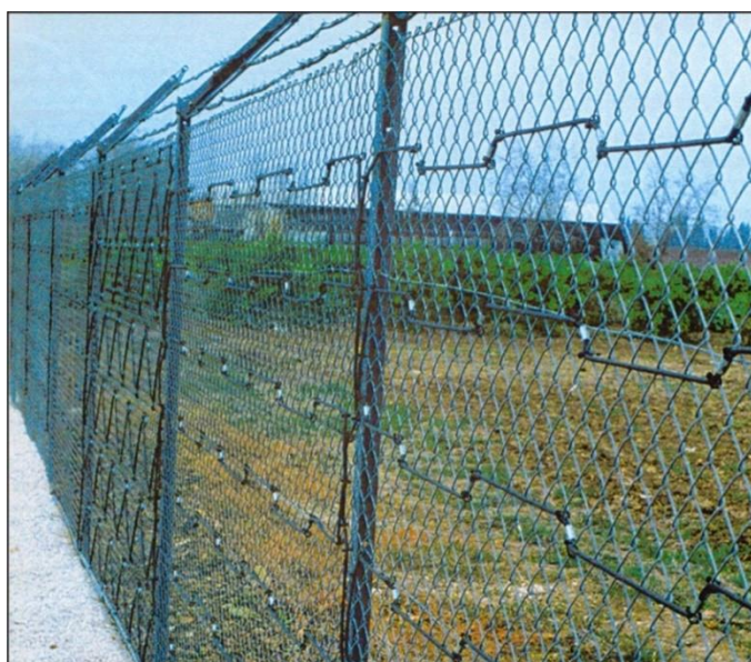
Slika 7. Prikaz načina postavljanja senzorskog vodiča na ogradu
