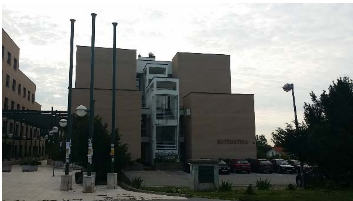
Slika 2. Zgrada Matematičkog odsjeka
