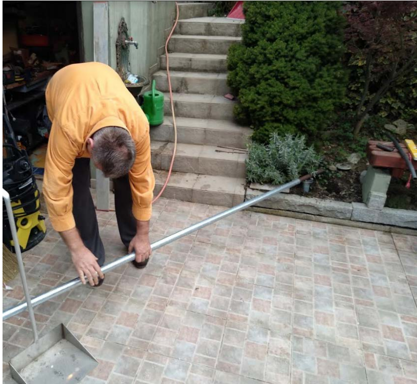
Slika 35. Ručno postavljanje sidrenog cjevastog vijka
