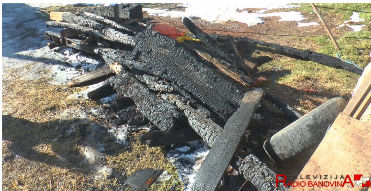
Slika 15. Izgorjela drvena građa s gospodarskog objekta štale.[26]
