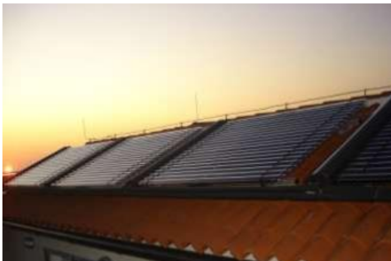
Slika 3.11. Vakuumski kolektori u vodoravnoj izvedbi, Pula [1]
