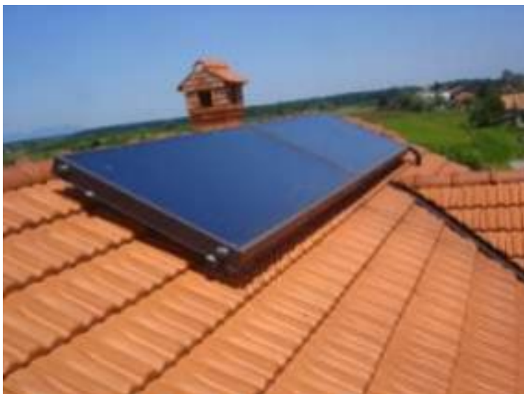
Slika 3.10. Pločasti kolektori u vodoravnoj izvedbi, Vodostaj – Karlovac [1]
