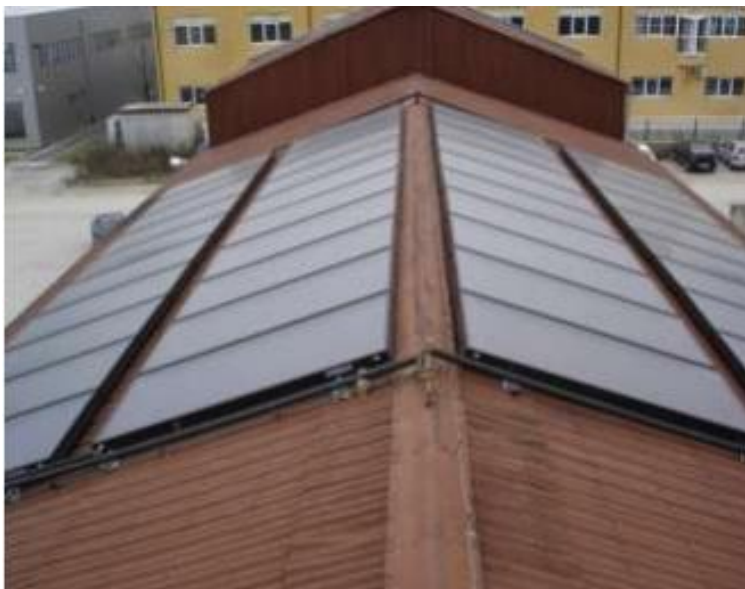
Slika 3.9. Pločasti kolektori u okomitoj izvedbi, Jankomir – Zagreb [1]
