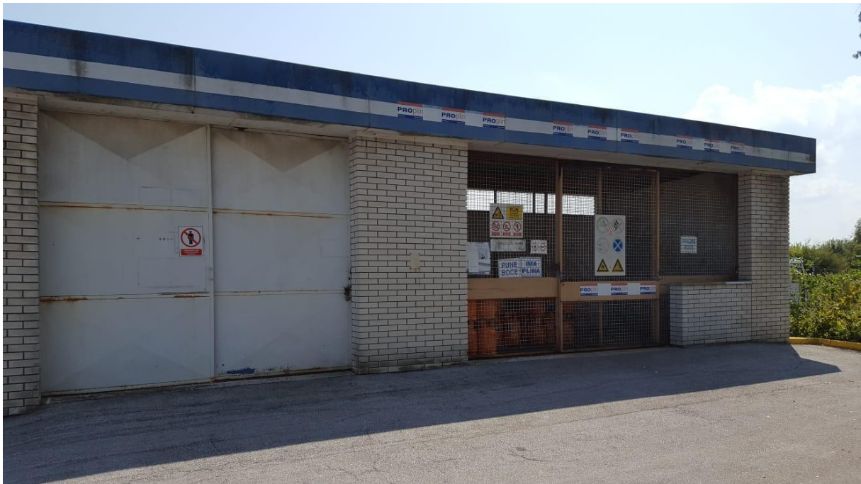
Slika 5. Skladište plinskih boca [4]
