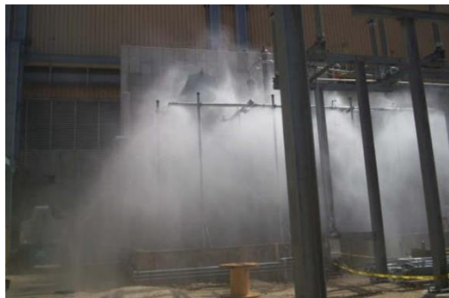
Slika 22. Aktivirani sustav za gašenje vodenom maglom [17]
