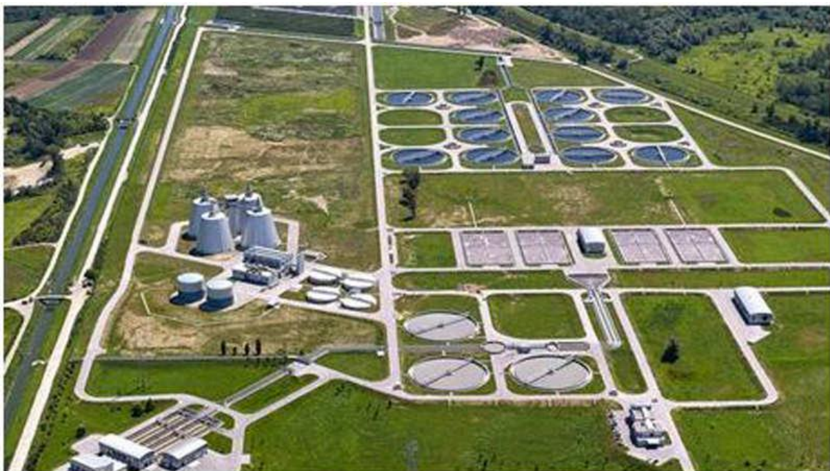
Slika 12. Centralni uređaj za pročišćavanje otpadnih voda Zagreb
