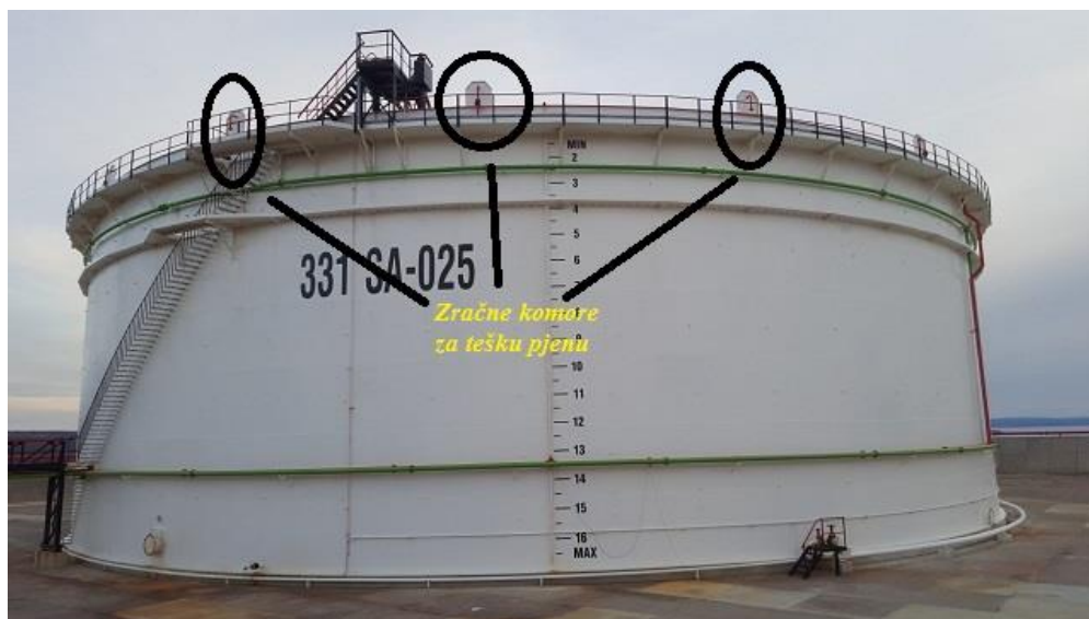
Sl. 8. Spremnik s plutajućim krovom [9]
