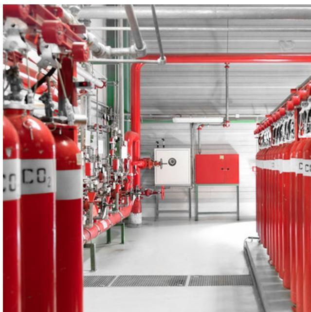
Slika 11. Prikaz stabilnog sustava za gašenje CO<sub>2</sub> [17]
