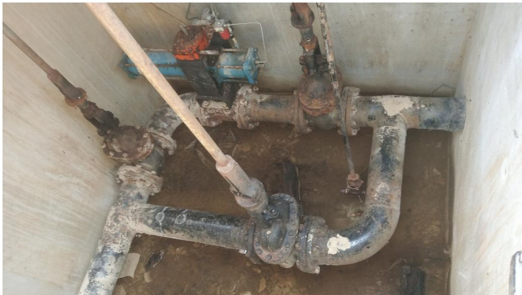
Slika 26 Zasunsko okno s aktivacijskim uređajem stabilnog sustava s raspršenom vodom (drencher) [14]
