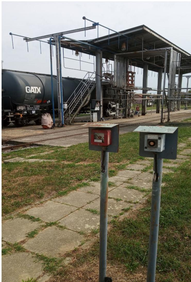
Slika 30. Drencher stabilni sustav na vagon pretakalištu i tipkala za aktivaciju sustava [14]
