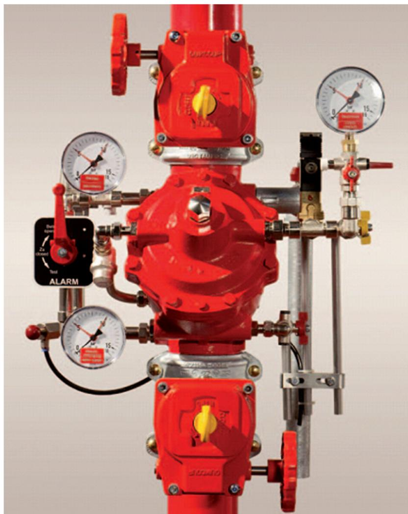
Slika 12. Drencher uređaj za aktivaciju, [16]
