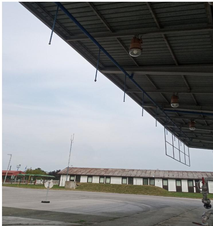
Slika 25 Prikaz drencher sustava auto punilište [14]
