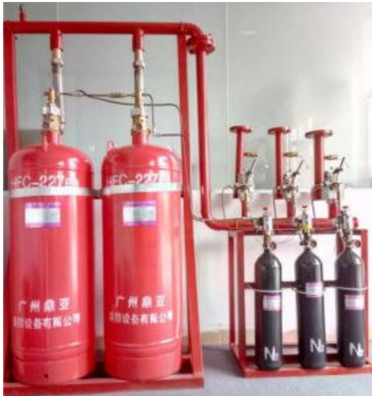
Slika 10 Primjer stabilnog sustava za gašenje požara FM 200, [15]
