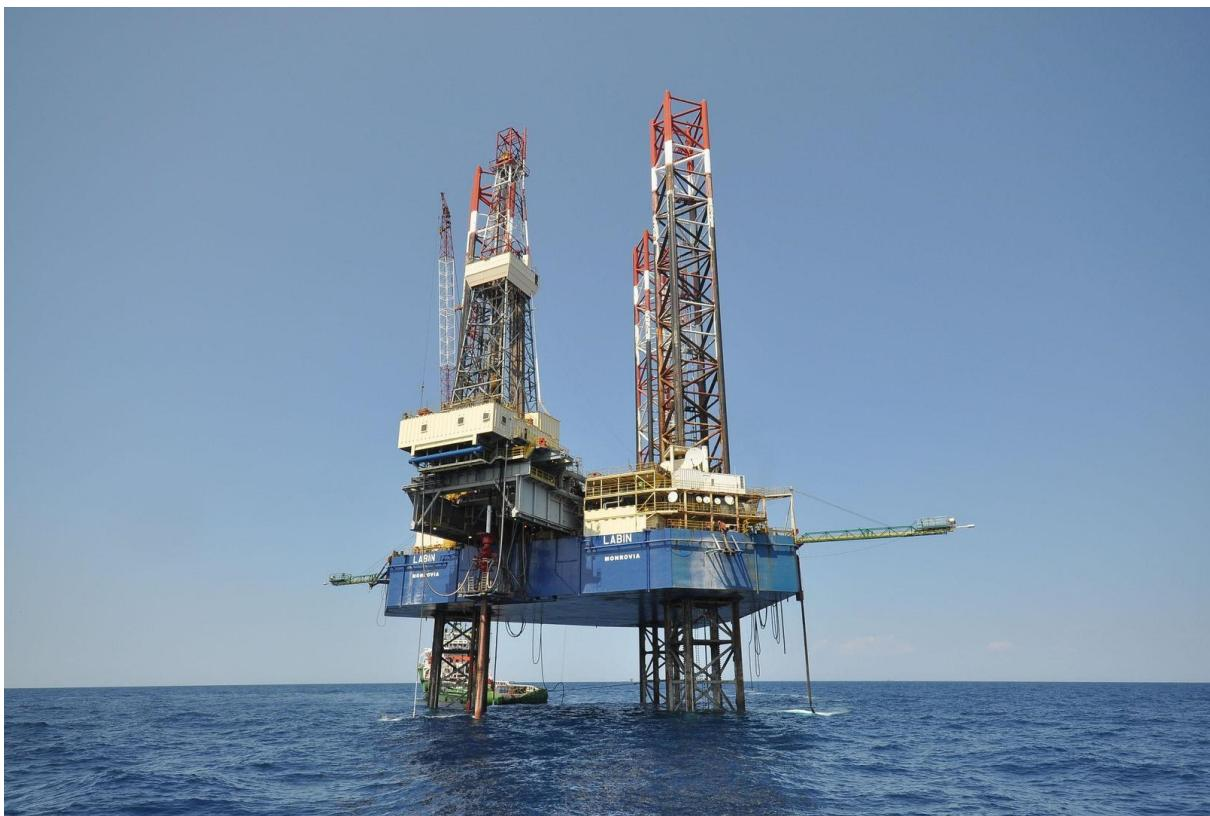
Slika 2. Prikaz bušeće naftne platforme [5]
