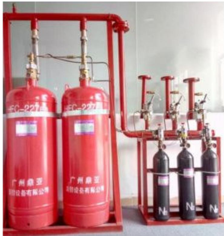
Slika 10 Primjer stabilnog sustava za gašenje požara FM 200, [15]
