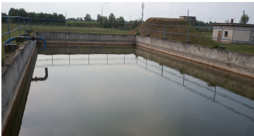
Slika 17 Primjer poluukopanog spremnika za vodu [14]
