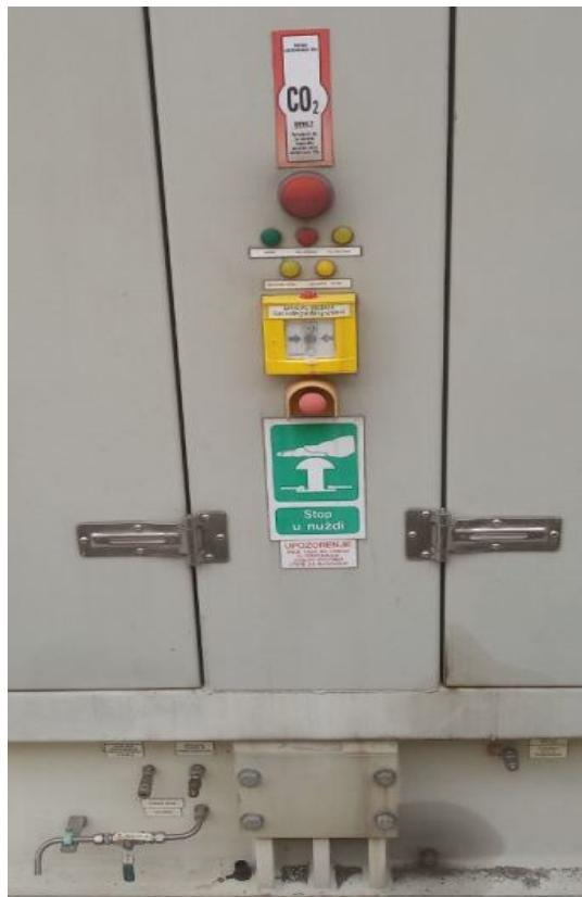
Slika 21. Prikaz tipkala za aktivaciju sustava za gašenje požara sa CO<sub>2</sub> [14]
