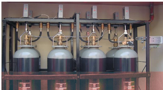
Slika 14. Sustav za gašenje ugljičnim dioksidom [14]
