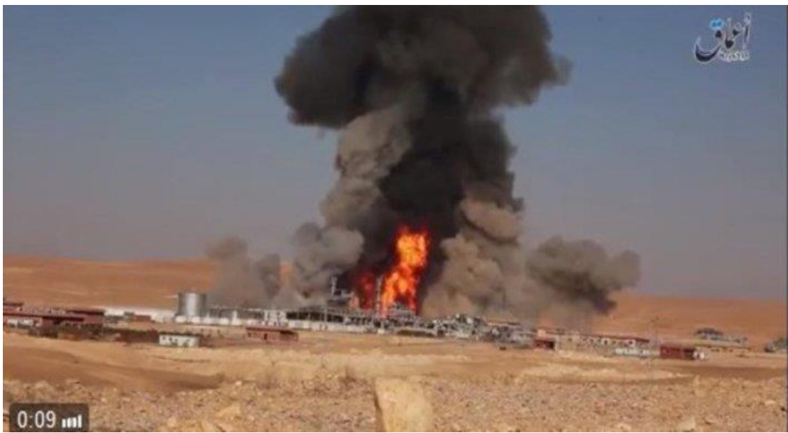
Slika 3. Plinsko postrojenje INA-e u Siriji dignuto u zrak [29]
