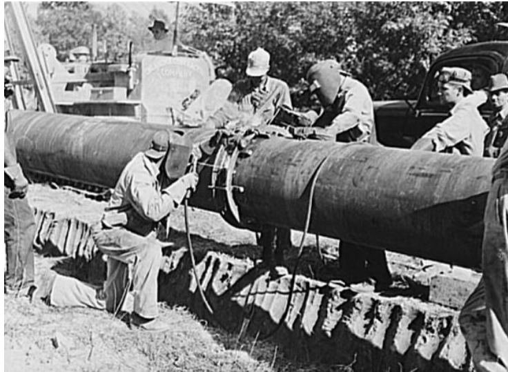
Slika 1. 1942. godina, zavarivanje cjevovoda velikih dimenzija [4]
