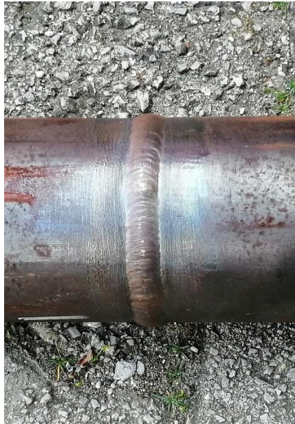
Slika 45. Ispitani sučeoni zavar na cijevnom sklopu
