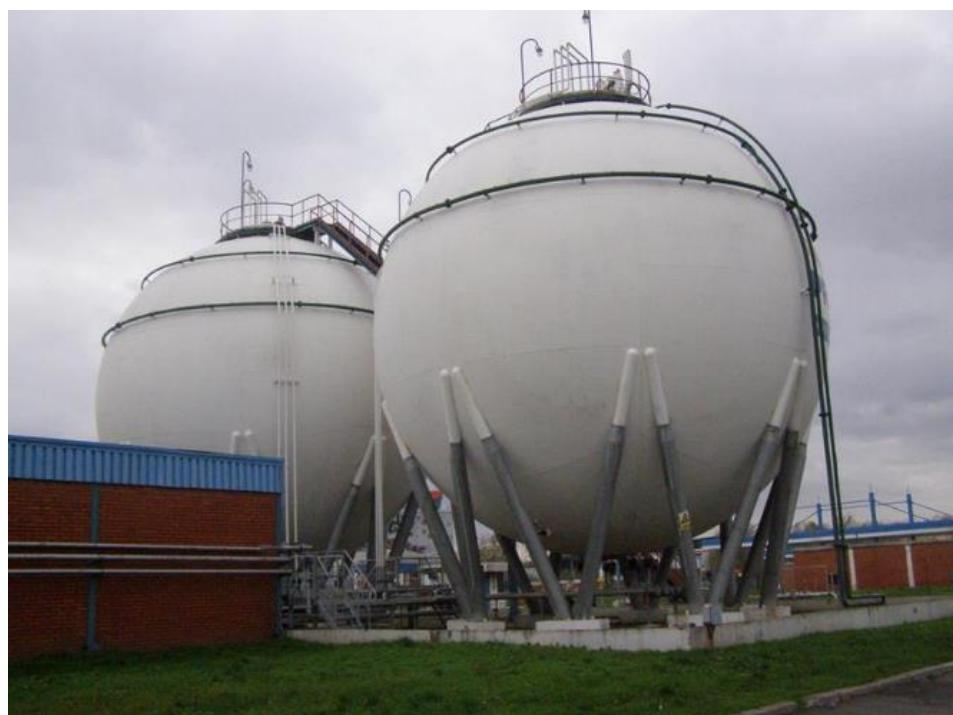
Slika 12. Kuglasti spremnik UNP-a "kugla" [2]
