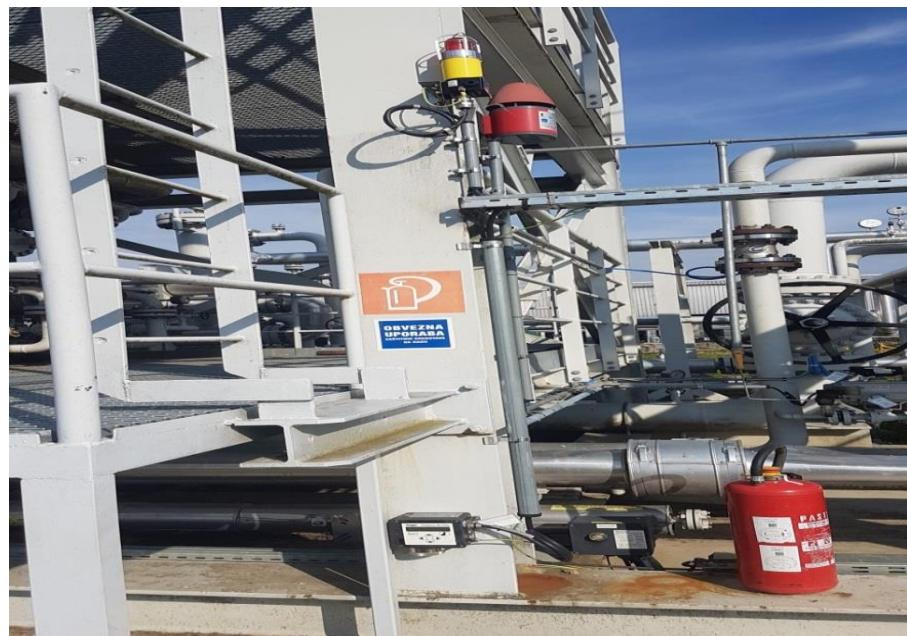
Slika 34. Stabilni detektor CO<sub>2</sub>
