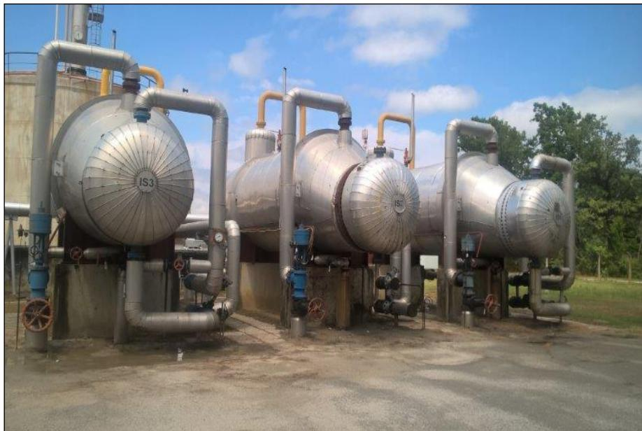
Slika 5. Izmjenjivači topline IS-3, IS-2, IS-1 [2]
