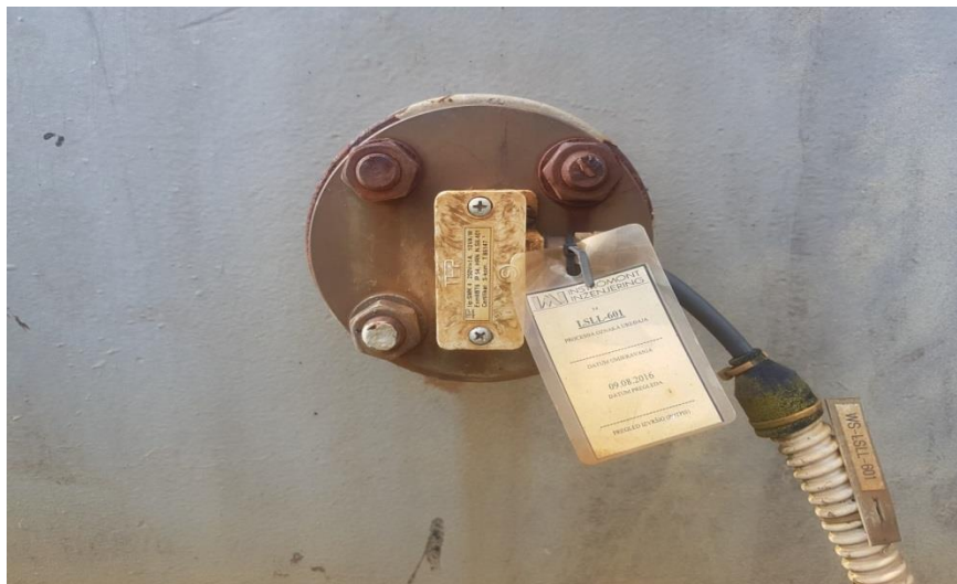
Slika 29. SMK (sklopka magnetna kontaktna)
