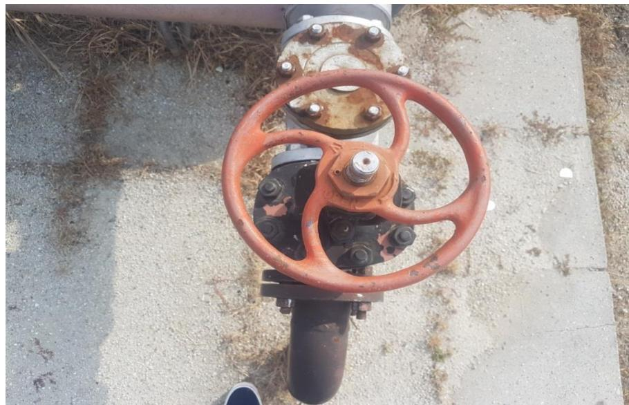
Slika 20. Protupovratna klapna
