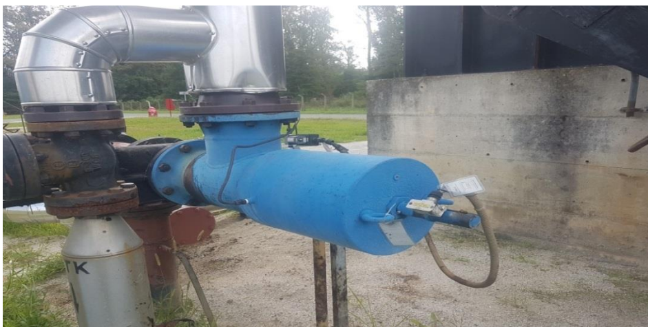
Slika 24. Blokadni ventil
