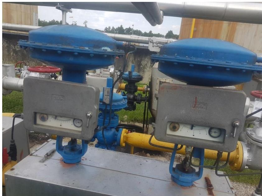
Slika 25. Regulatori na plinskoj rampi s uređajima za postavljanje vrijednosti tlaka
