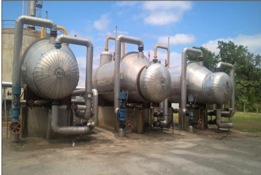
Slika 5. Izmjenjivači topline IS-3, IS-2, IS-1 [2]
