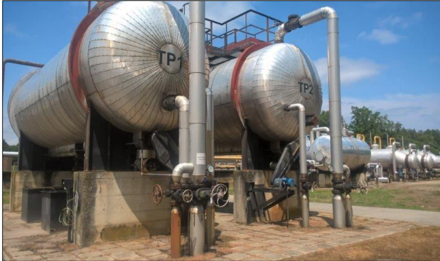
Slika 3. Taložnici pijeska TP-1 i TP-2 [2]
