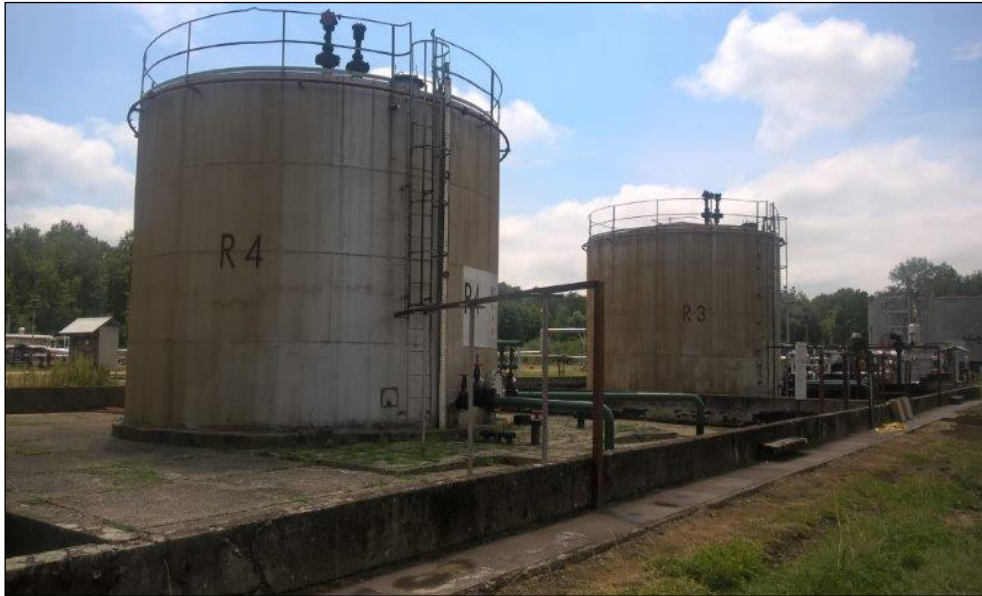
Slika 8. Spremnici suhe nafte 250 m 3 R-3 i R-4 [2]
