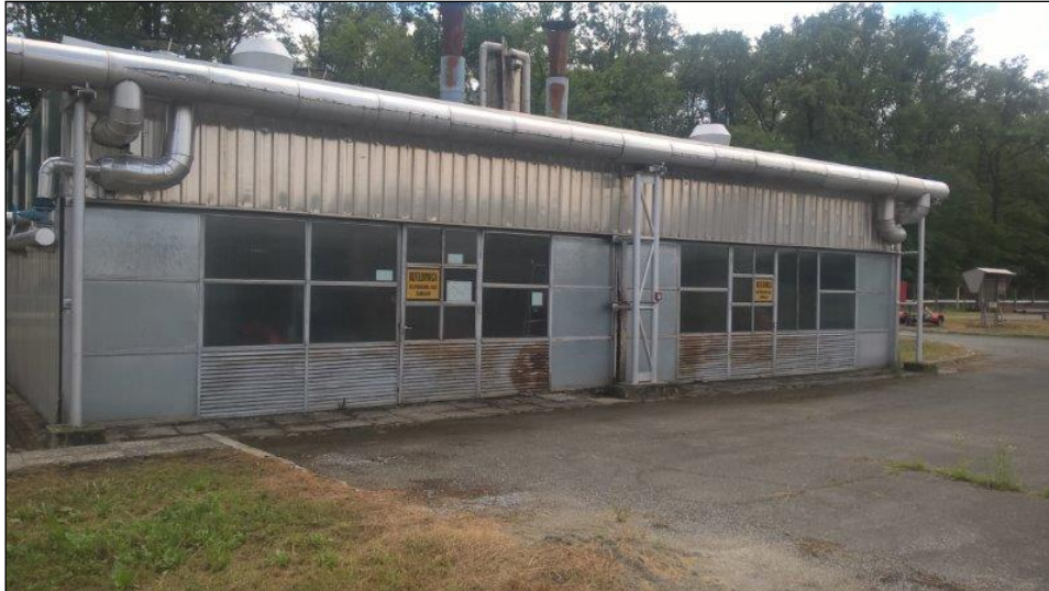
Slika 16. Kotlovnica OS Žutica [2]
