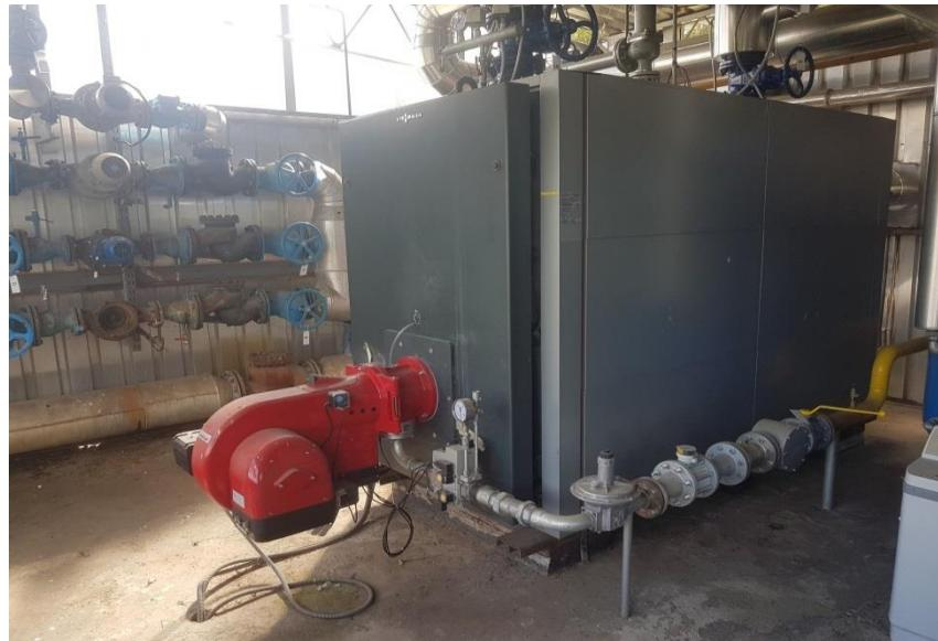
Slika 27. Regulator tlaka u kotlovnici
