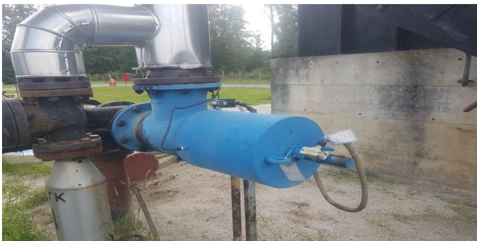
Slika 24. Blokadni ventil
