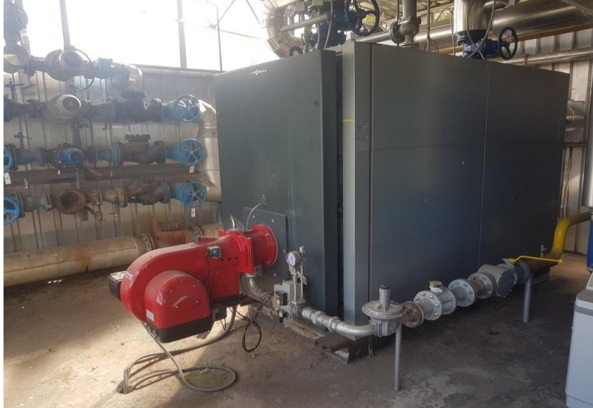
Slika 27. Regulator tlaka u kotlovnici
