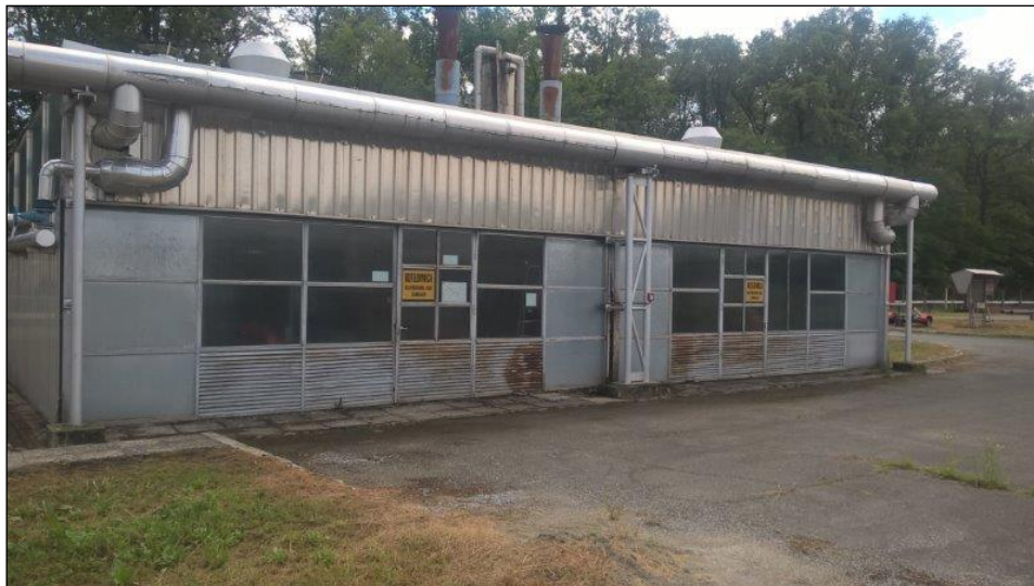
Slika 16. Kotlovnica OS Žutica [2]
