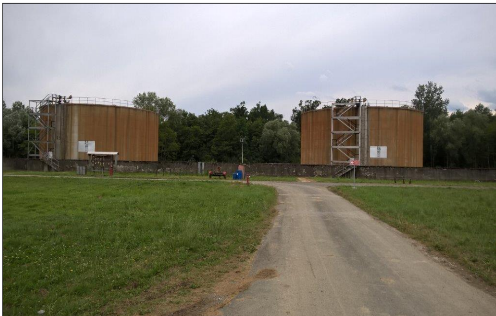
Slika 10. Spremnici suhe nafte R-5 i R-6 [2]
