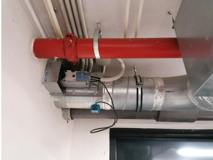
Sl. 19. Protupožarna zaklopka [24]
