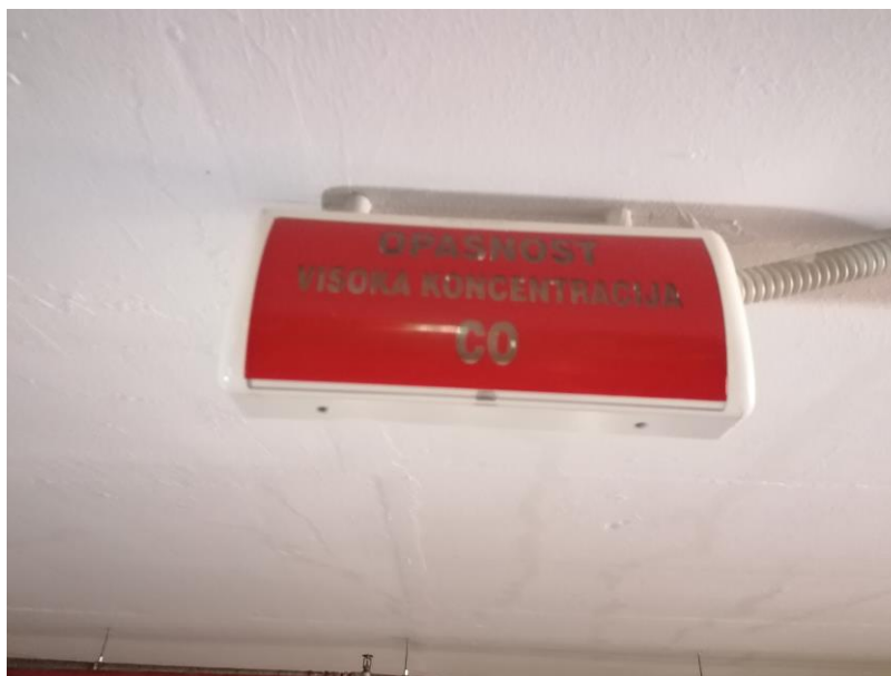
Sl. 21. Svjetlosna signalizacija opasnosti visoke koncentracije CO [24]
