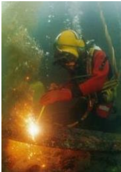
SLIKA 6. podvodno rezanje elektrodom
