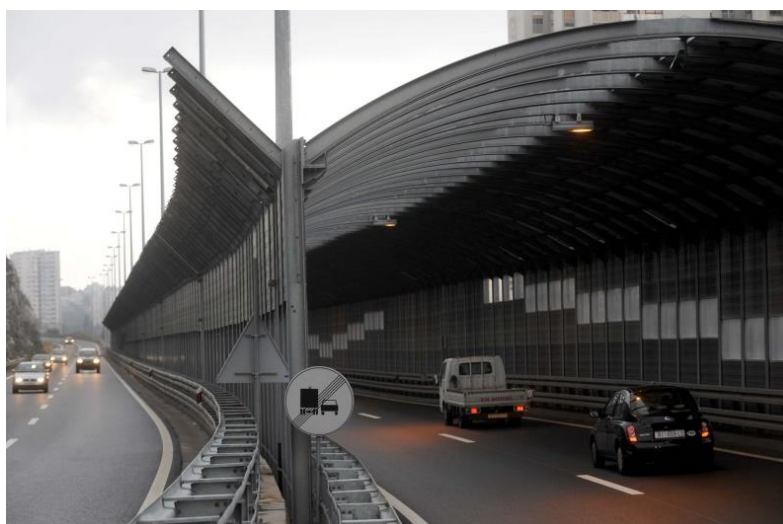
Slika 10. 2. Zid za zaštitu od buke - Rijeka
