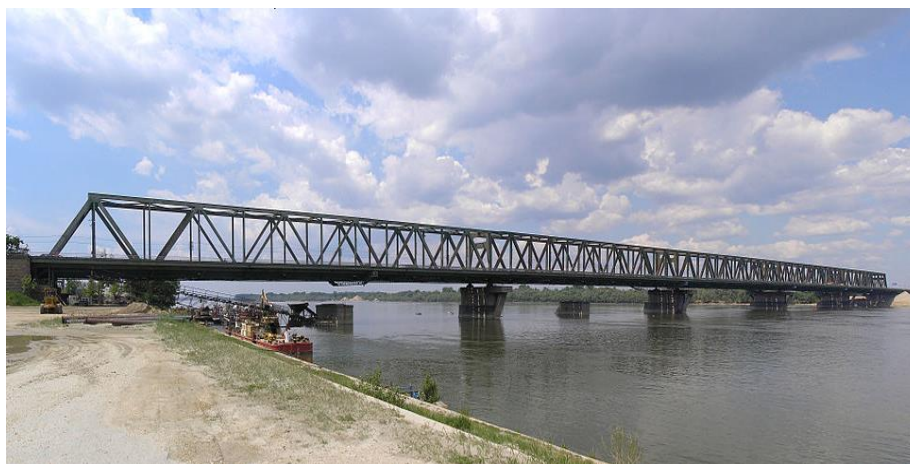
Slika 1.2. Rešetkasta konstrukcija u mostogradnji [2]
