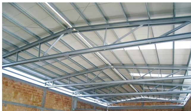
Slika 1.3. Krovni nosač [3]
