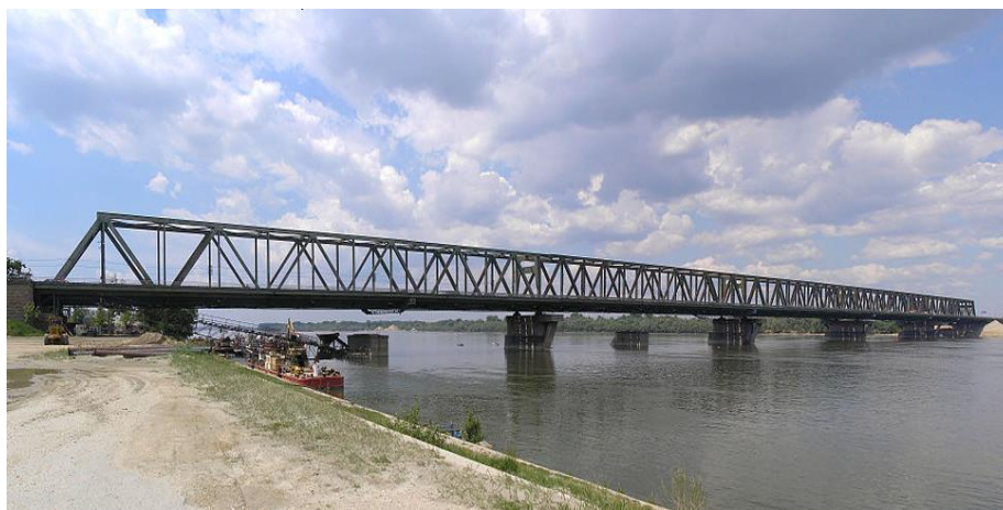
Slika 1.2. Rešetkasta konstrukcija u mostogradnji [2]
