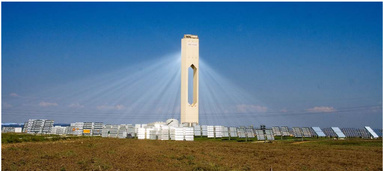
Slika 5. Solarni koncentrirani sustav sa tornjem [3]
