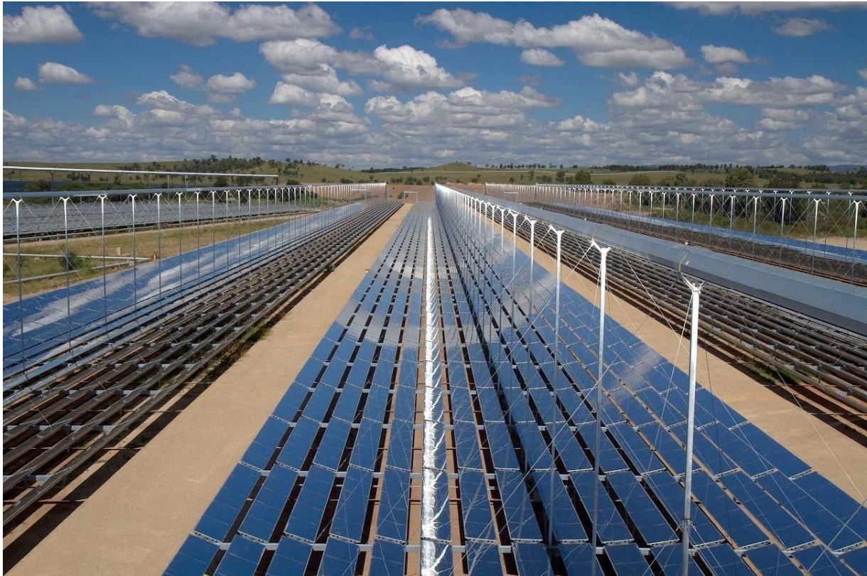
Slika 9. Fresnelov solarni sustav u primjeni (Elektrana Novatec Australija) [6]
