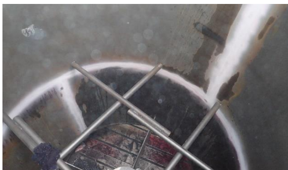
Slika 44. Ispitivanje zavora sa unutarnje strane izlazne cijevi. [2]
