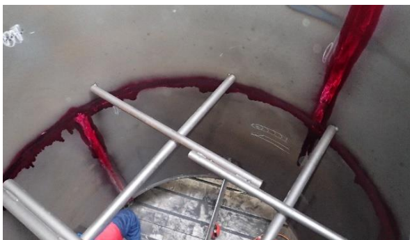
Slika 43. Ispitivanje zavora sa unutarnje strane izlazne cijevi. [2]
