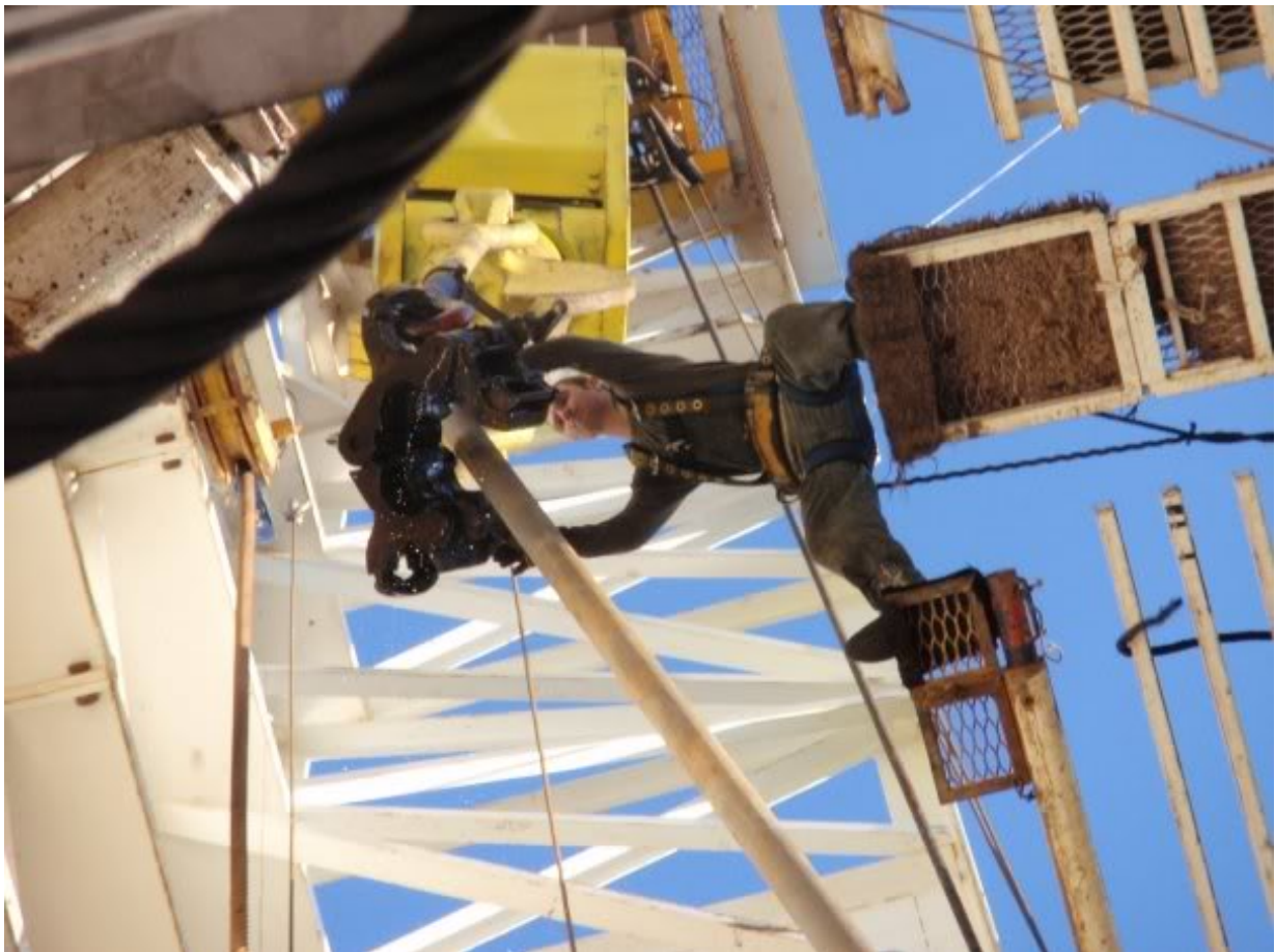
Slika 40. Tornjaš ubacuje šipku u elevator
