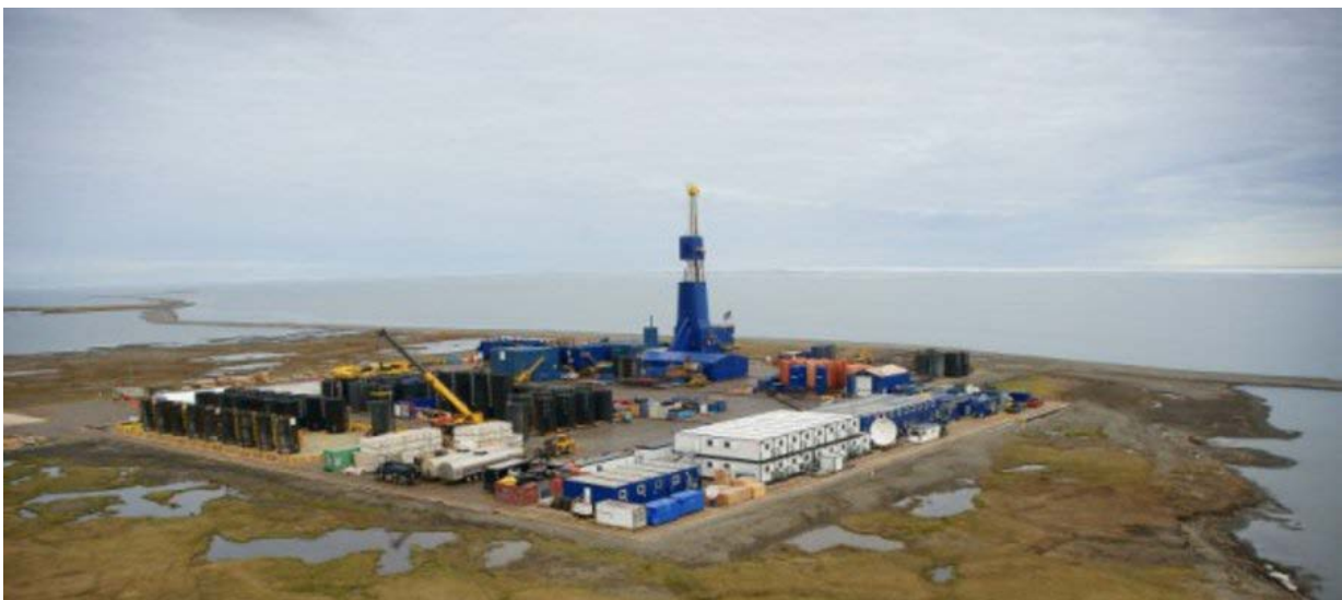
Slika 19. Primjer bušaćeg postrojenja za ekstremno hladne uvijete sa postavljenim oplatama
