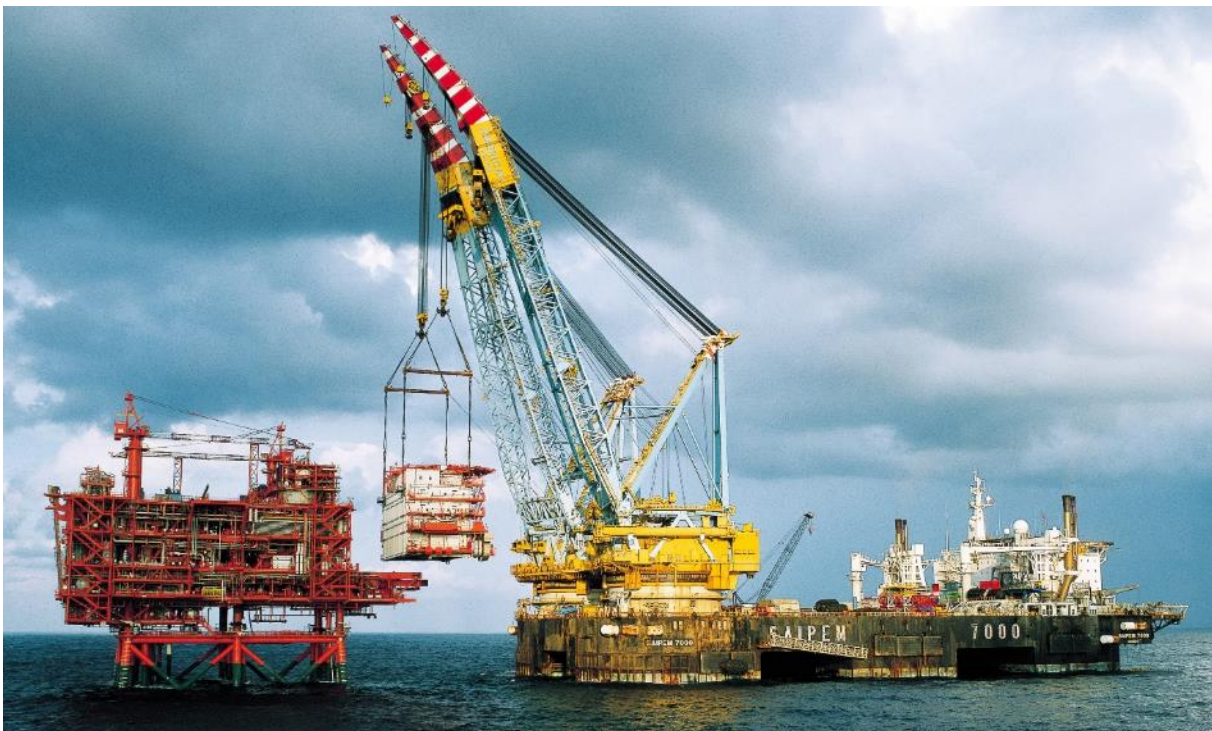
Slika 16. Saipem 7000 i zadizanje stambenog bloka u Libiji
