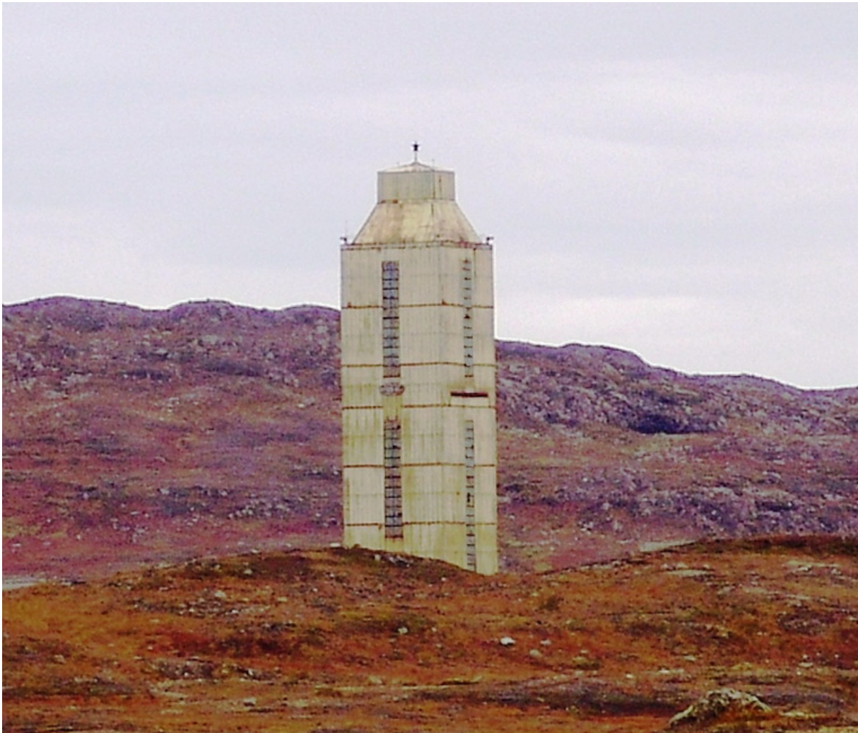
Slika 2. Struktura Kola bušačeg postrojenja sa zaštitnom oplatom za zaštitu od hladnoće
