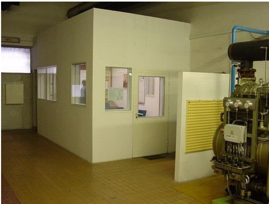
Slika 15. Primjer zvučno izolirane kontrolne sobe
