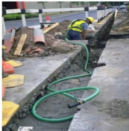
Slika 19 Cijevni uređaj sa svježim zrakom
