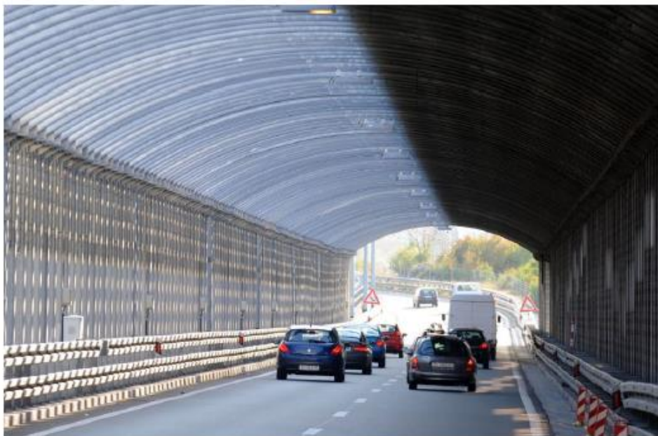
Slika 25. Zid za zaštitu od buke na Riječkoj obilaznici
