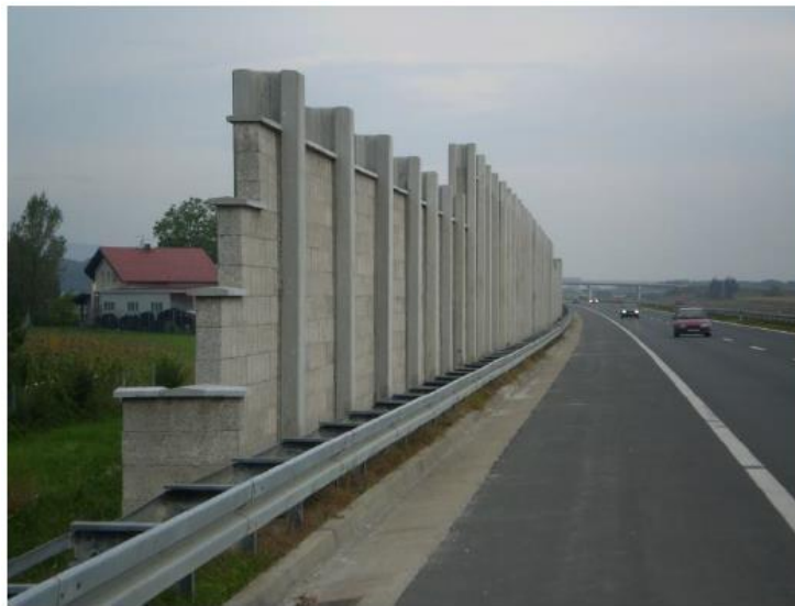
Slika 15. Zidovi za zaštitu od buke
