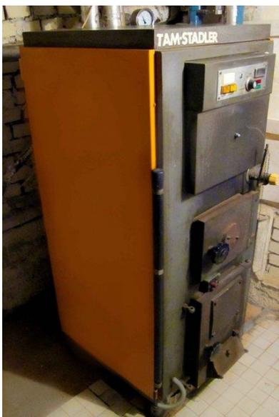
Slika 3. Stari tip peći na ulje/plin [3]
