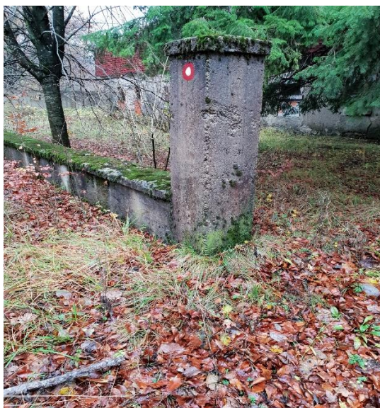
Slika br. 12 lokacija br. 2 Gumance – visina do 70 cm na kojoj je pronađen materijal - beton
