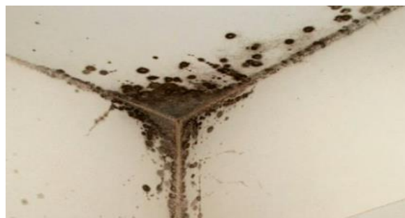
Slika 18. Vlaga u kutevima unutarnjeg prostora [29]
