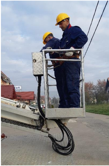
Slika 12. Pravilno rukovanje i vezanje zaposlenika sigurnosnim užetom u košari auto-platforme
