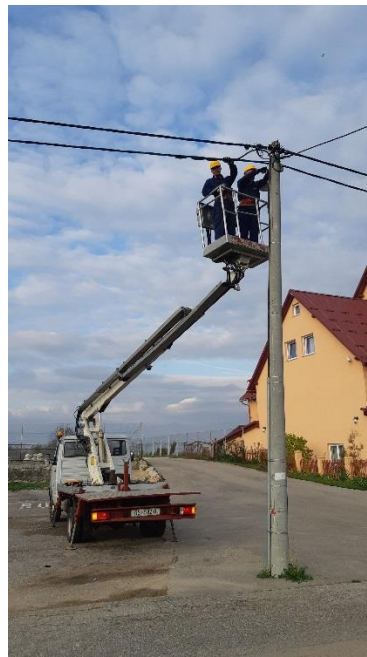
Slika 13. Prikaz popravka električne instalacije u beznaponskom stanju na javnoj rasvjeti
