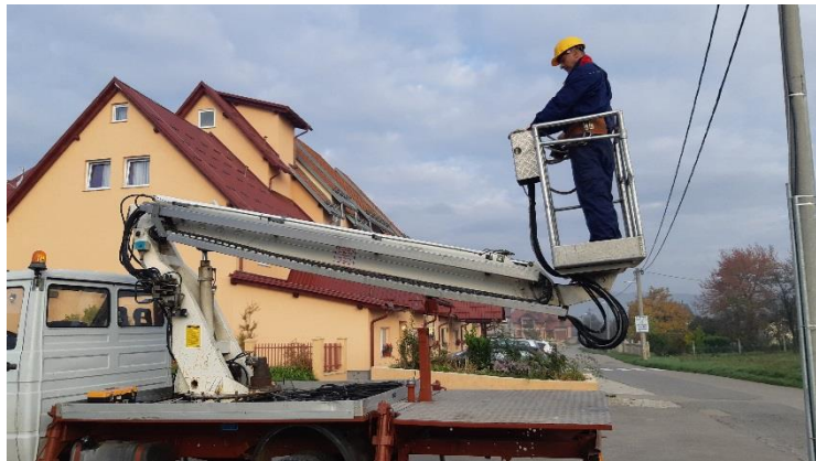
Slika 12. Pravilno rukovanje i vezanje zaposlenika sigurnosnim užetom u košari auto-platforme
