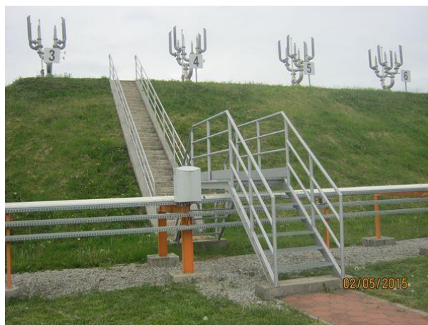
Slika 4. Spremnici terminala s brojevima spremnika
