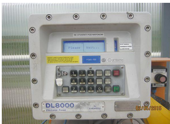
Slika 27. Računalo protoka
