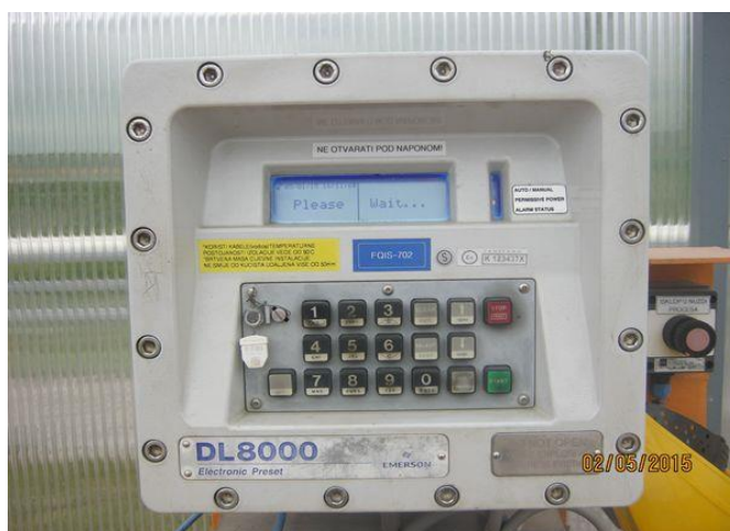
Slika 27. Računalo protoka
