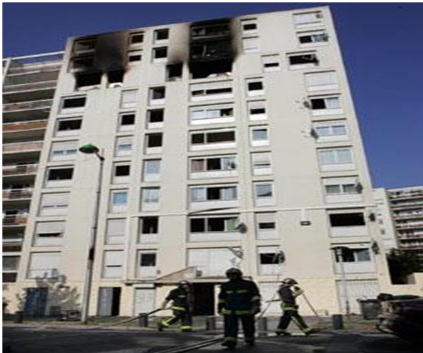
Slika 1. Posljedica požara na višem objektu
