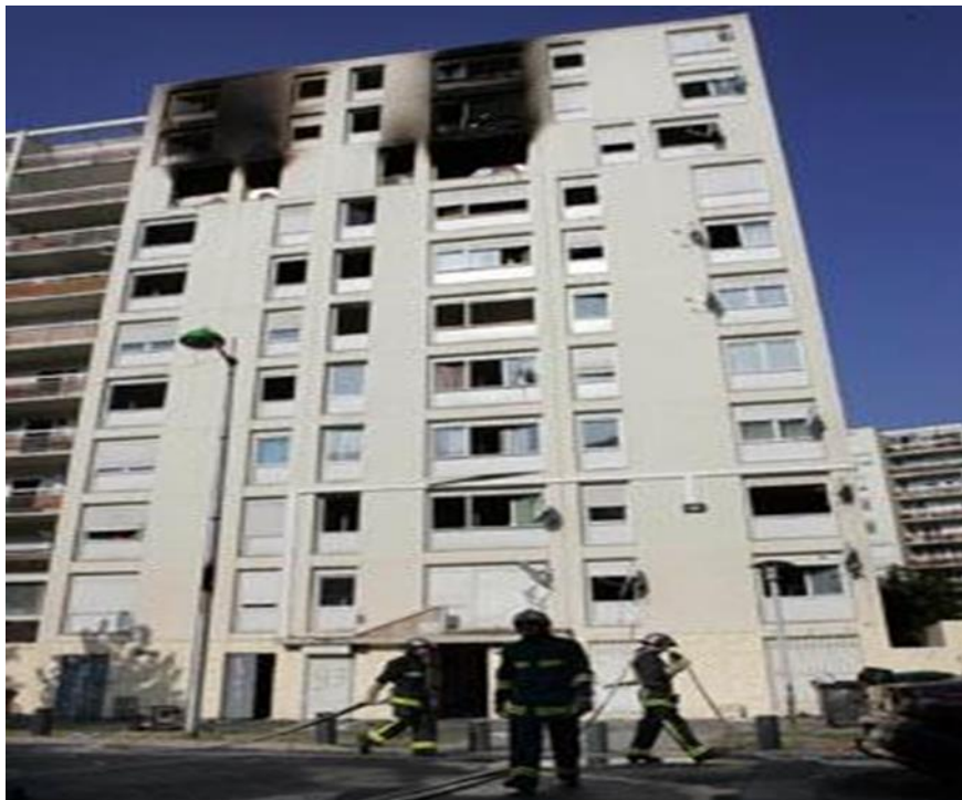
Slika 1. Posljedica požara na višem objektu
