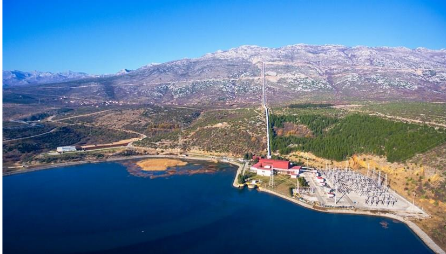
Slika 9. Reverzibilna hidroelektrana Velebit [17]
