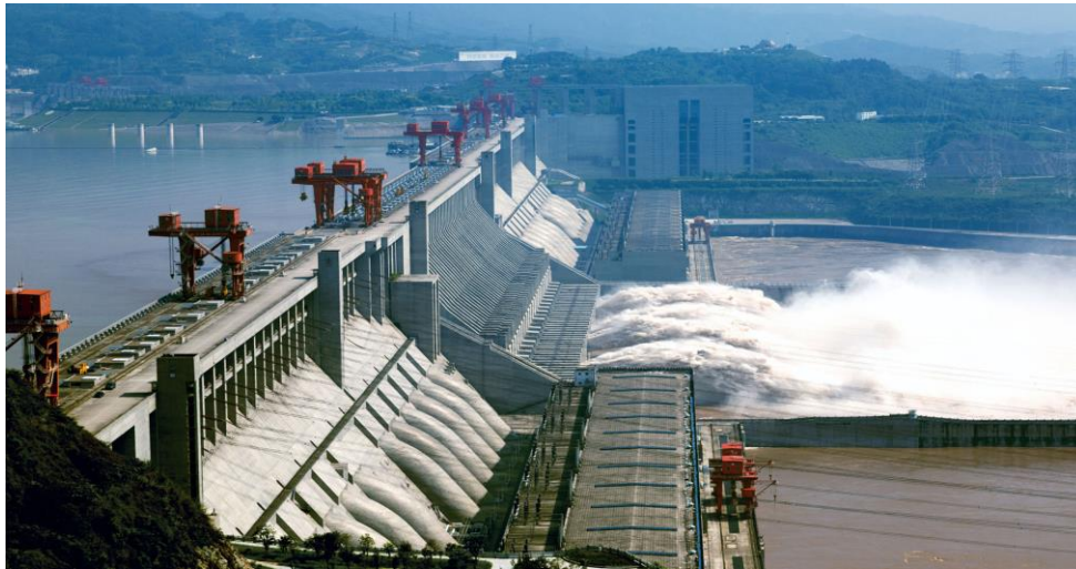
Slika 17. Hidroelektrana Tri klanca [26]
