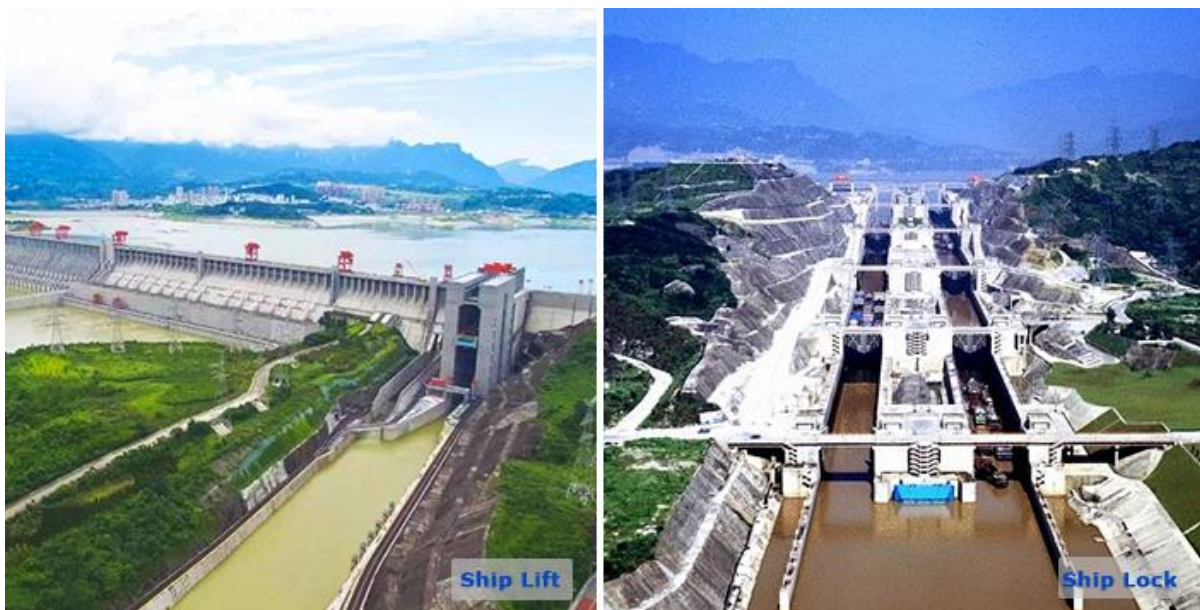
Slika 27. Brodsko dizalo i prevodnica na hidroelektrani Tri klanca [51]
