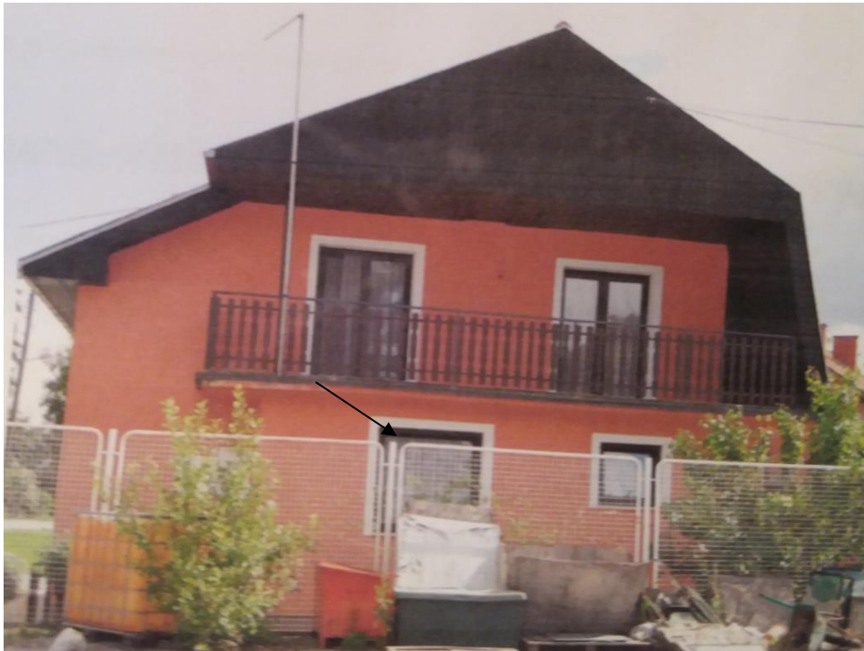
Slika 14. Predodžba prozora na kojem je došlo do provale: Izvorno autorica
