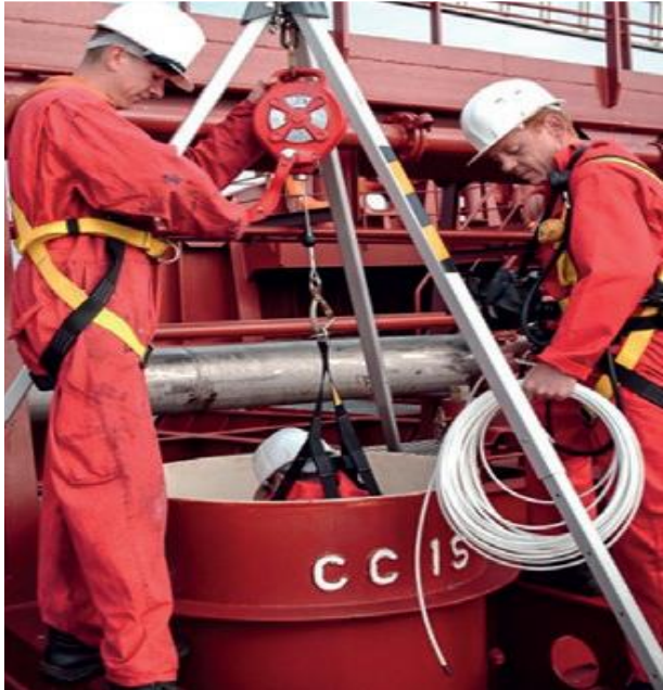
Slika 11. Vježba za ulazak u zatvoreni proctor 1
