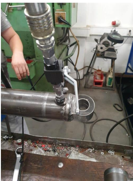
Slika 92. Zatvoren ventil priključnice (1).
