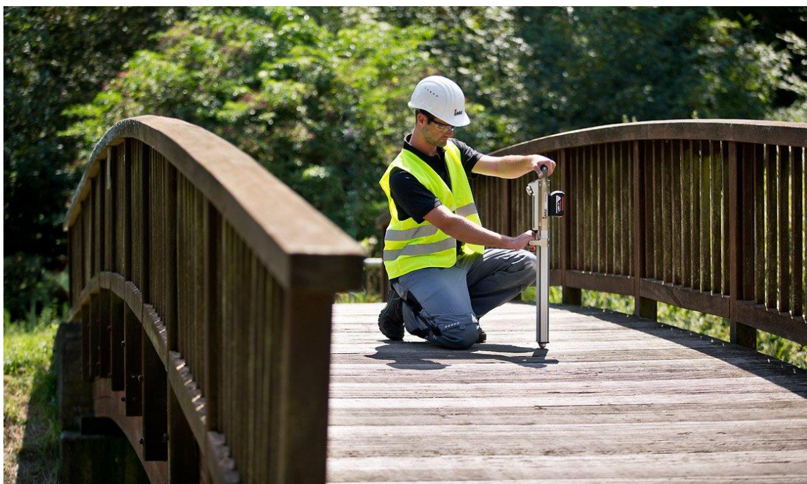
Slika 3. Ispitivanje stanja drvenog mosta rezistografom
