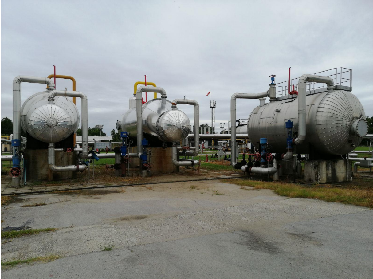
Slika 4. Izmjenjivači topline [19]
