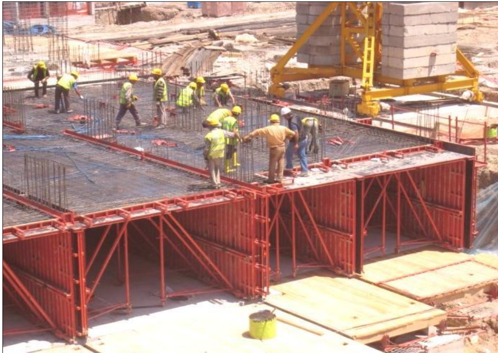
Slika 9. Tunelska oplata-školjka
