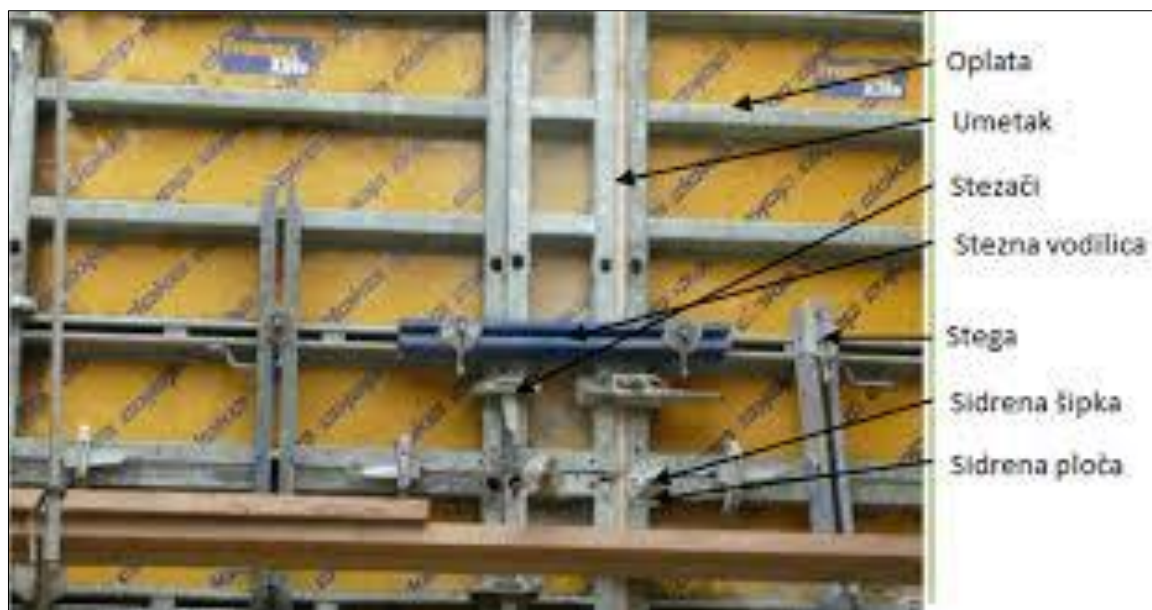
Slika 5. Dijelovi za spajanje oplata
