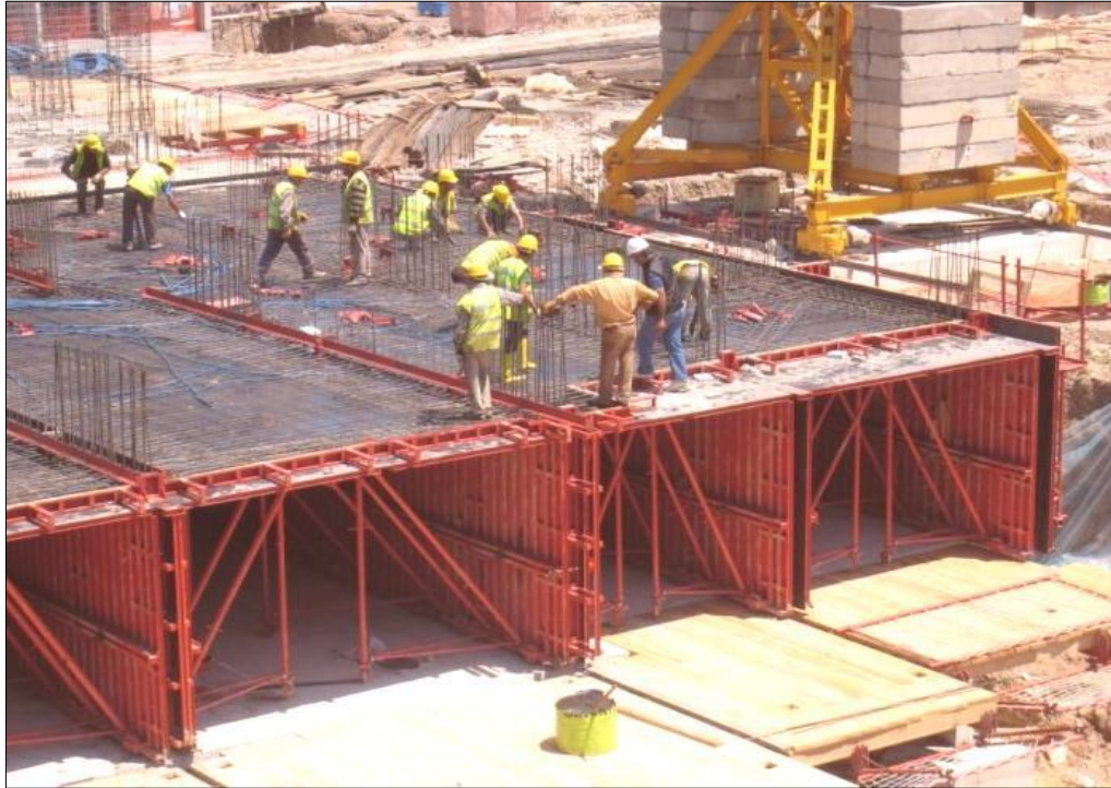
Slika 9. Tunelska oplata-školjka
