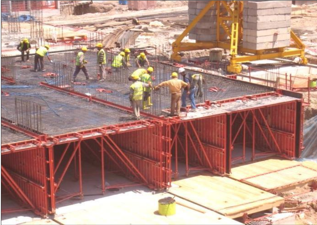
Slika 9. Tunelska oplata-školjka
