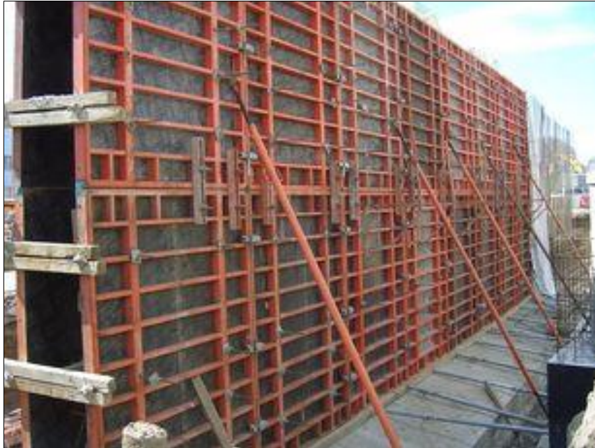
Slika 4. Velikoplošna oplata za vertikalne konstrukcije
