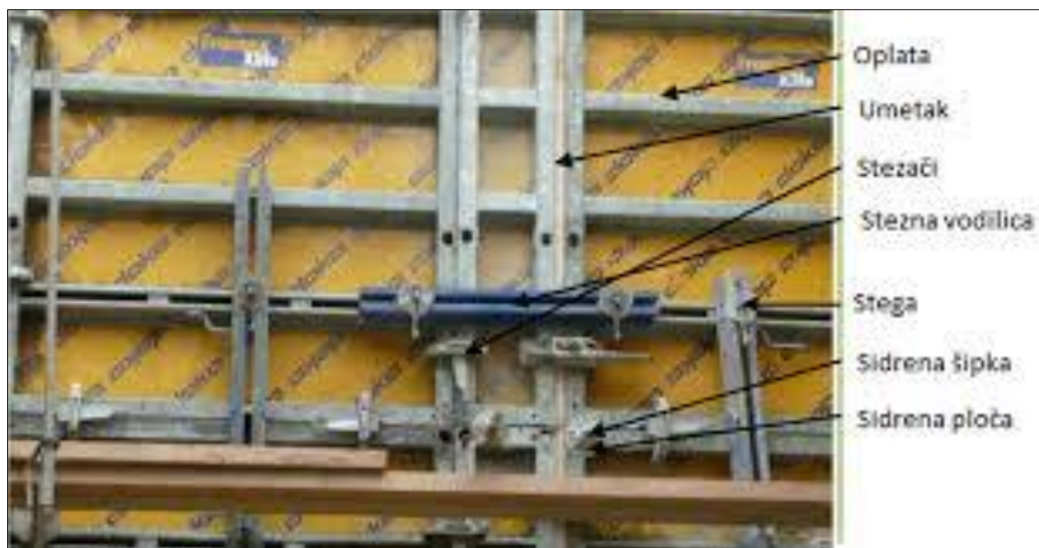
Slika 5. Dijelovi za spajanje oplata
