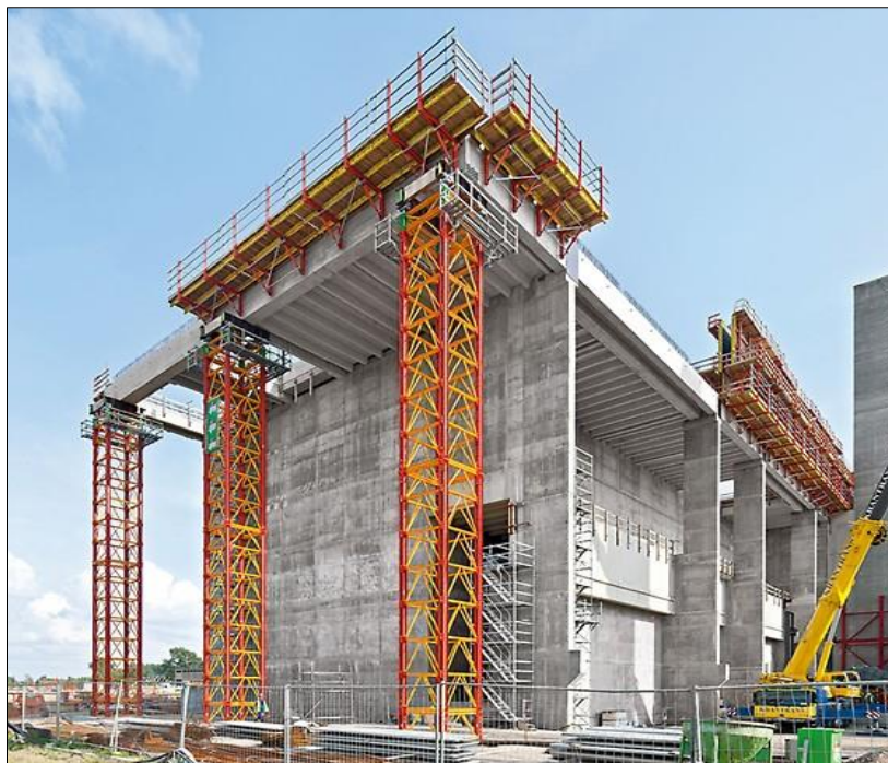
Slika 18. Upotreba skela za pridržavanje konstrukcija pri njihovoj montaži
