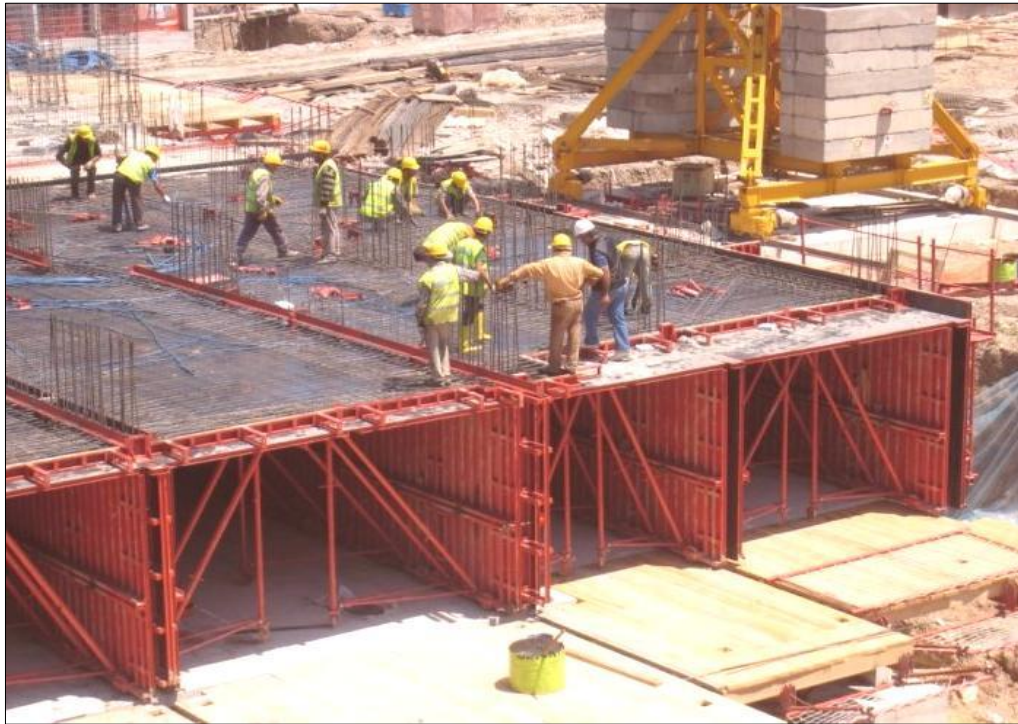
Slika 9. Tunelska oplata-školjka
