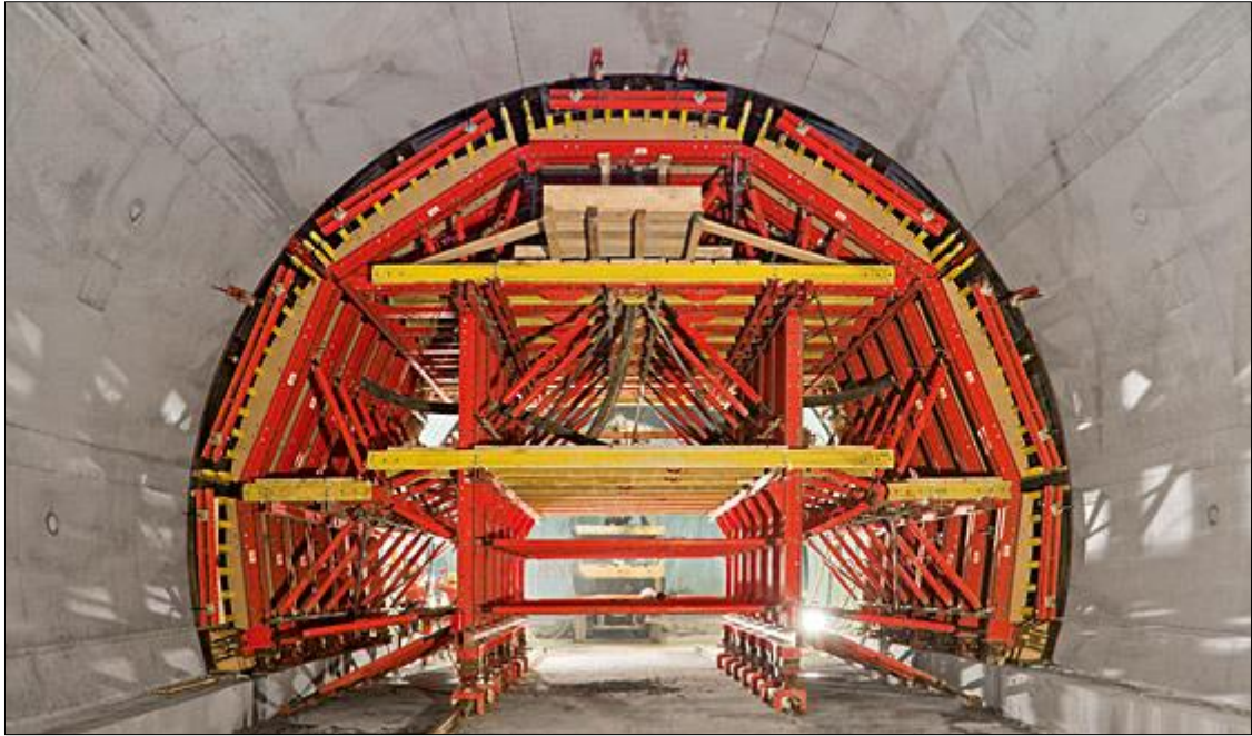
Slika 7. Tunelska oplata
