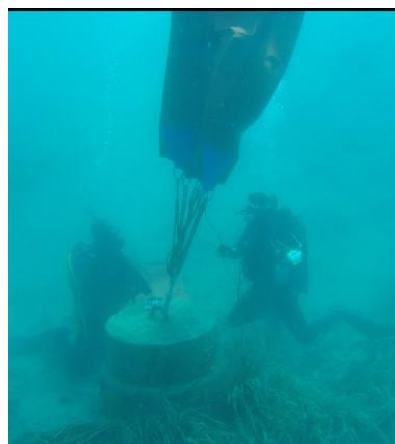
Sl. 35. Postavljanje i napuhavanje padobrana [3]
