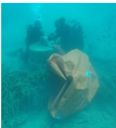
Sl. 35. Postavljanje i napuhavanje padobrana [3]
