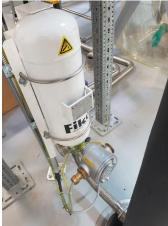
Slika 26. Dušikom se guši širenje eksplozije u postrojenju – tlačni osjetnik detektira nagli porast tlaka. Ovo nije jedini primjer korištenja inertnih plinova, neka postrojenja rade u potpuno inertnoj atmosferi kako bi se spriječio nastanak eksplozije
