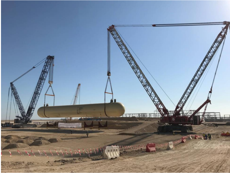
Slika 7. Pozicioniranje spremnika na temelje Izvor: https://www.petrofac.com/petrofacts/bullets/
